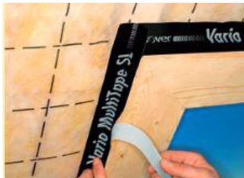
Obr. 56: Napojení parozábrany na okenní rám (zdroj: [44])
