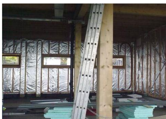
Obr. 53: Vzduchotěsná vrstva z fólie lehkého typu (zdroj: Archiv autora)
