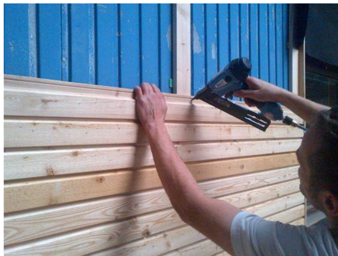
Obr. 15: Montáž palubek (zdroj: [11])
