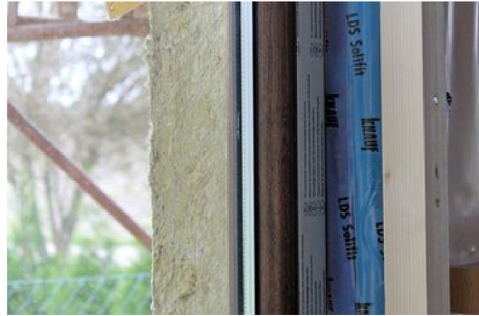
Obr. 65: Správné napojení parozábrany na okenní rám 2 (zdroj: [49])
