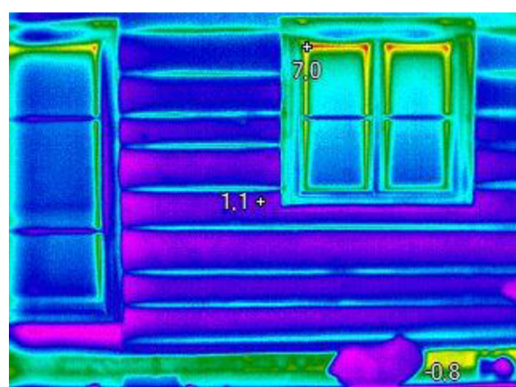
Obr. 78: Termogram sruhu 4 (zdroj: Archiv autora)
