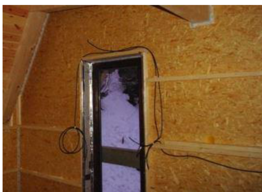
Obr. 52: Vzduchotěsná vrstva z OSB (zdroj: [42])
