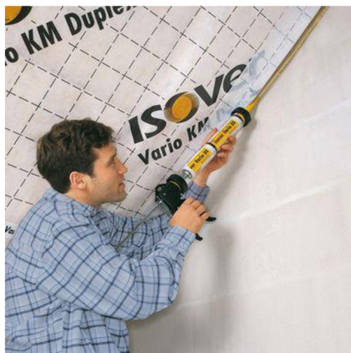
Obr. 58: Spojení tmelem s navazující konstrukcí (zdroj: [44])
