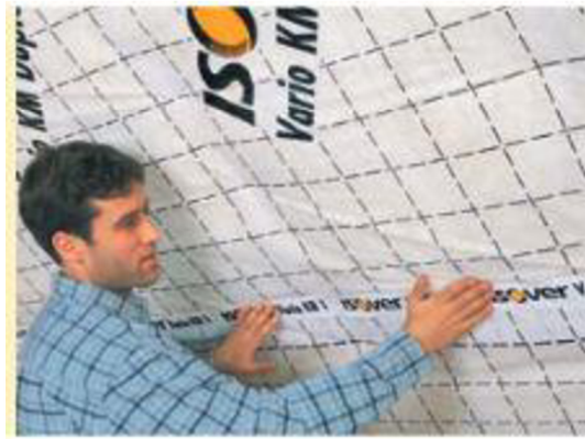
Obr. 55: Zalepení kotvicích prvků páskou (zdroj: [44])
