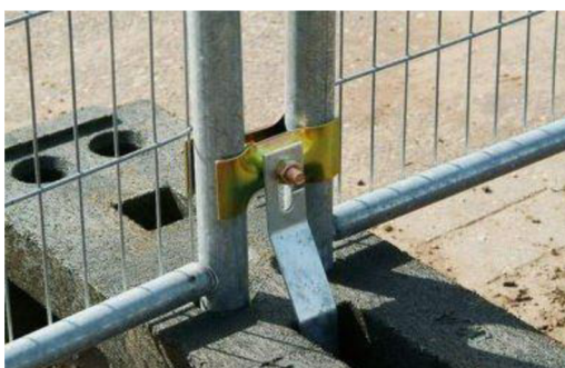
Obr. 22: Pojistka proti vyháknutí (zdroj: [16])
