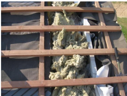
Obr. 66: Rozpad minerální vlny vlivem infiltrace (zdroj: [50])
