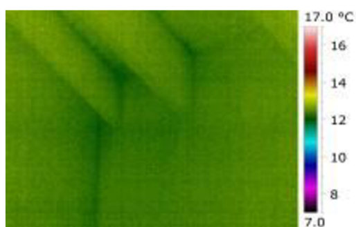
Obr. 69: Termogram správně provedené parozábrany (zdroj: [42])
