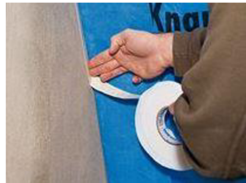
Obr. 57: Spojení páskou s navazující konstrukcí (zdroj: [45])
