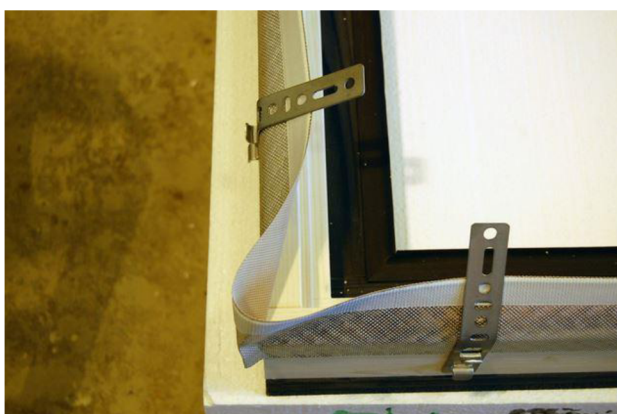
Obr. 5: Montáž pásových kotev (zdroj: [3])
