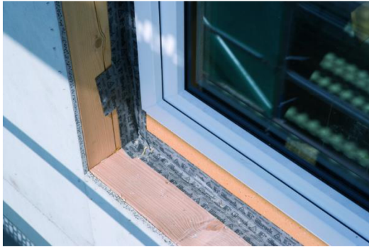
Obr. 64: Správné napojení parozábrany na okenní rám 1 (zdroj: [48])
