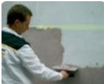
Obr. 21: Nanášení tenkovrstvé omítky (zdroj: [15])
