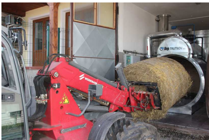
Obr.č.3 Kotel na slámu [22]
