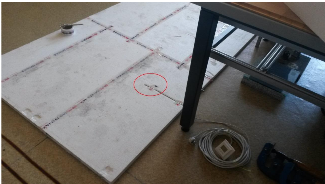
Obr. 34 - Umístění čidla termostatu pro regulaci teploty topných fólií
