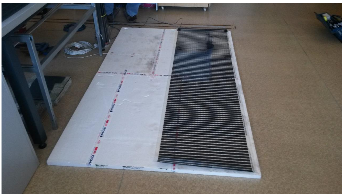
Obr. 35 - Vrstva spojené izolace a rozložené topné fólie
