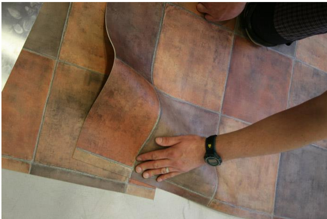
Obr. 23 – Podlahovina z PVC (PVC – pokládka)
