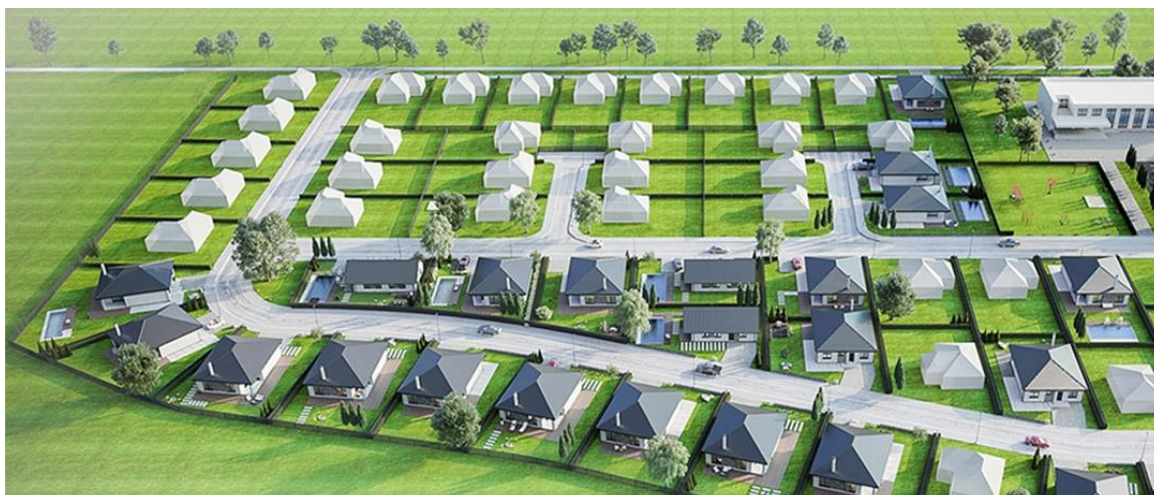
Obr.č.2: Pohled na zástavbu izolovaných rodinných domů (zdroj: Reins, 2002)
