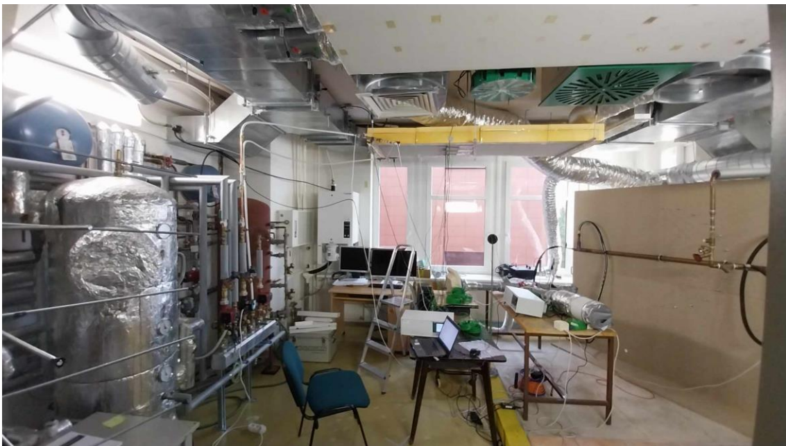
Obr. 26 Instalace měřeného a měřicího aparátu
