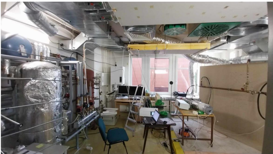
Obr. 26 Instalace měřeného a měřicího aparátu
