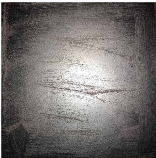
Obr. č. 25 Aplikace adhezniho můstku. Foto autor.
