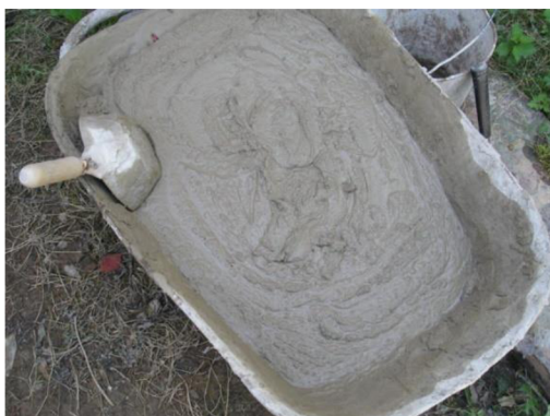
Obr. č. 2 Příprava omítky „in situ“ [29]
