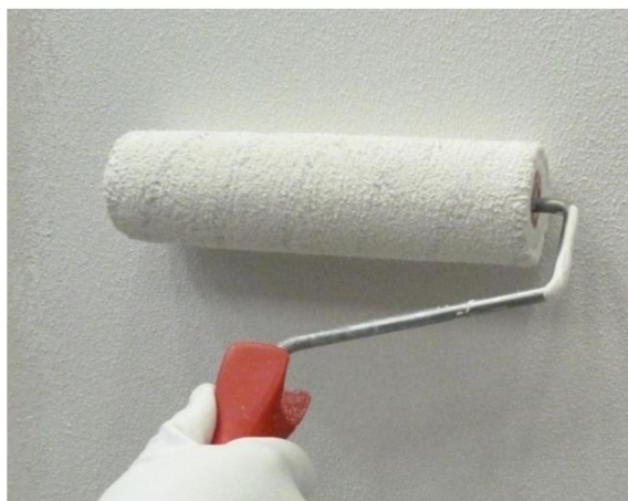
Obr. č. 3 Vertikální aplikace pastovité omítky válečkem. [30]
