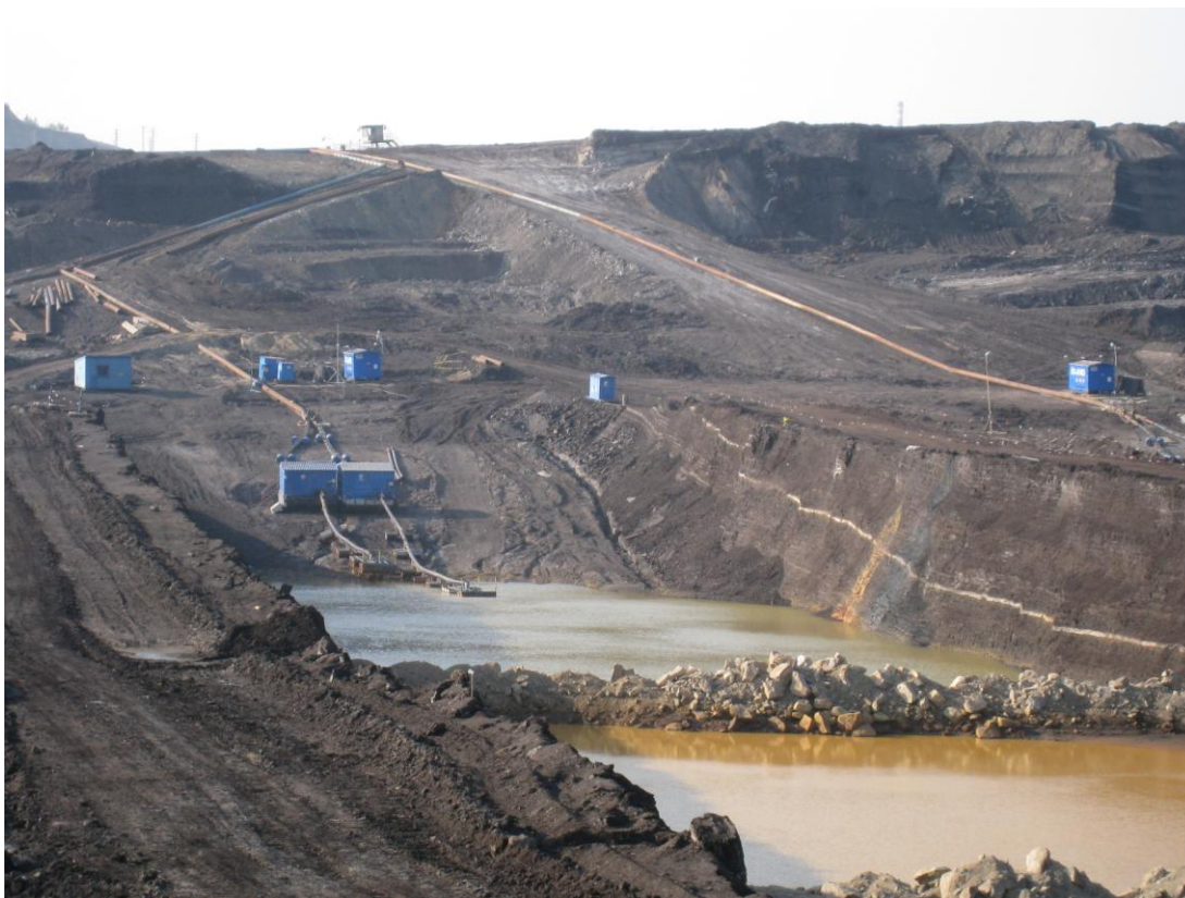
Obr. č. 13: Lom Jiří – Družba – čerpání důlních vod do úpravny ve Svatavě (Ančinec, 2013)
