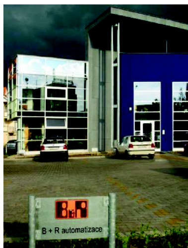
obr. 2: Budova brněnské pobočky B&R [4]
