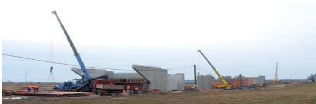
obr.č. 12 stavba přivaděče na Litoměřický most
