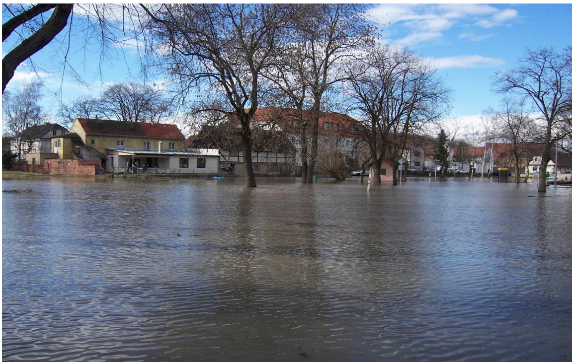
obr. č. 16 Povodeň, březen 2006 centrální část (náves) obce Loučky
