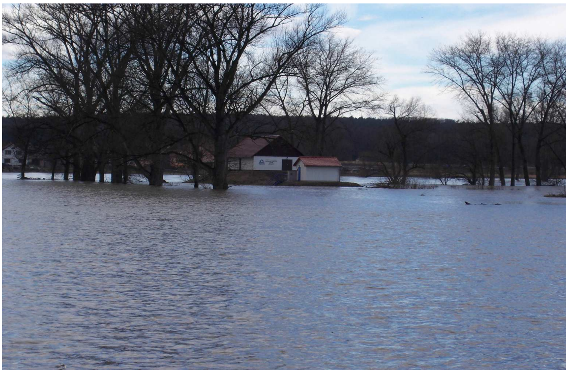
obr. č. 17 Povodeň, březen 2006 ČOV obce Lounky
