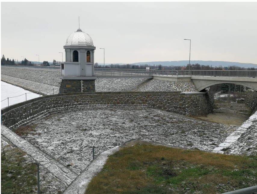
Obr. 74. Vodní nádrž Plumlov, bezpečnostní přeliv (Suchánek J., leden 2020)
