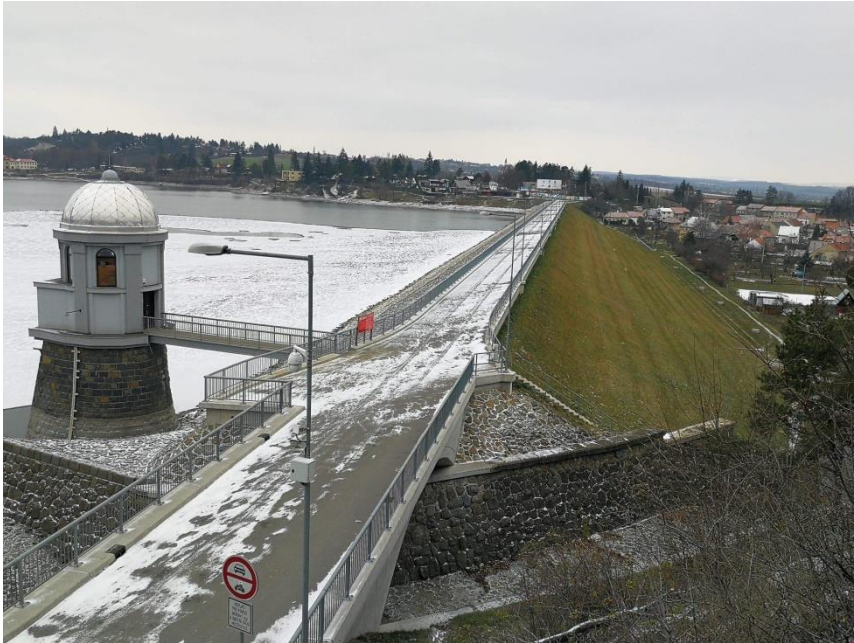
Obr. 73. Hráz vodní nádrže Plumlov (Suchánek J., leden 2020)
