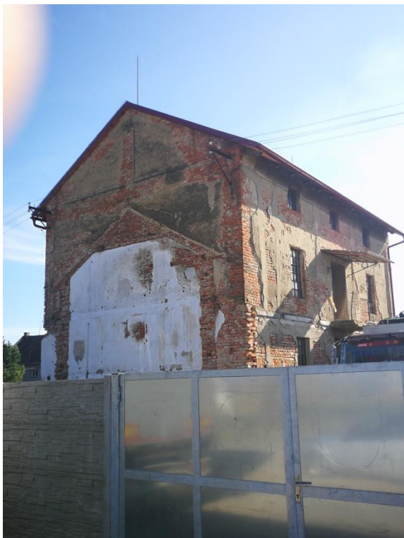
Obr. 22. Družstevní mlýn, pekárna a elektrárna (Suchánek J., březen 2020)
