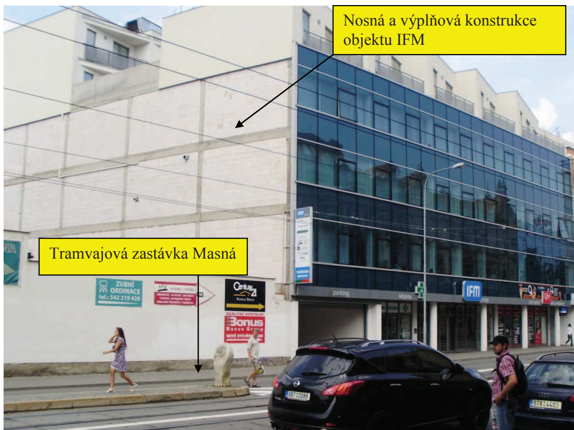
Obr. 5-4. Detailnější pohled na budovu IFM z jihozápadního směru.
