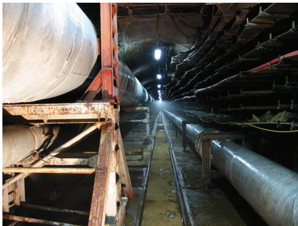
Obr. 8-2. Pohled do chodby kolektoru Svitavské nábřeží část E II
