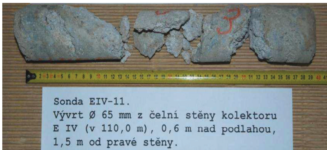
Obr. 4-9. Odebraný jádrový vývrt z čelní stěny kolektoru v pasu EIV-II. [14]
