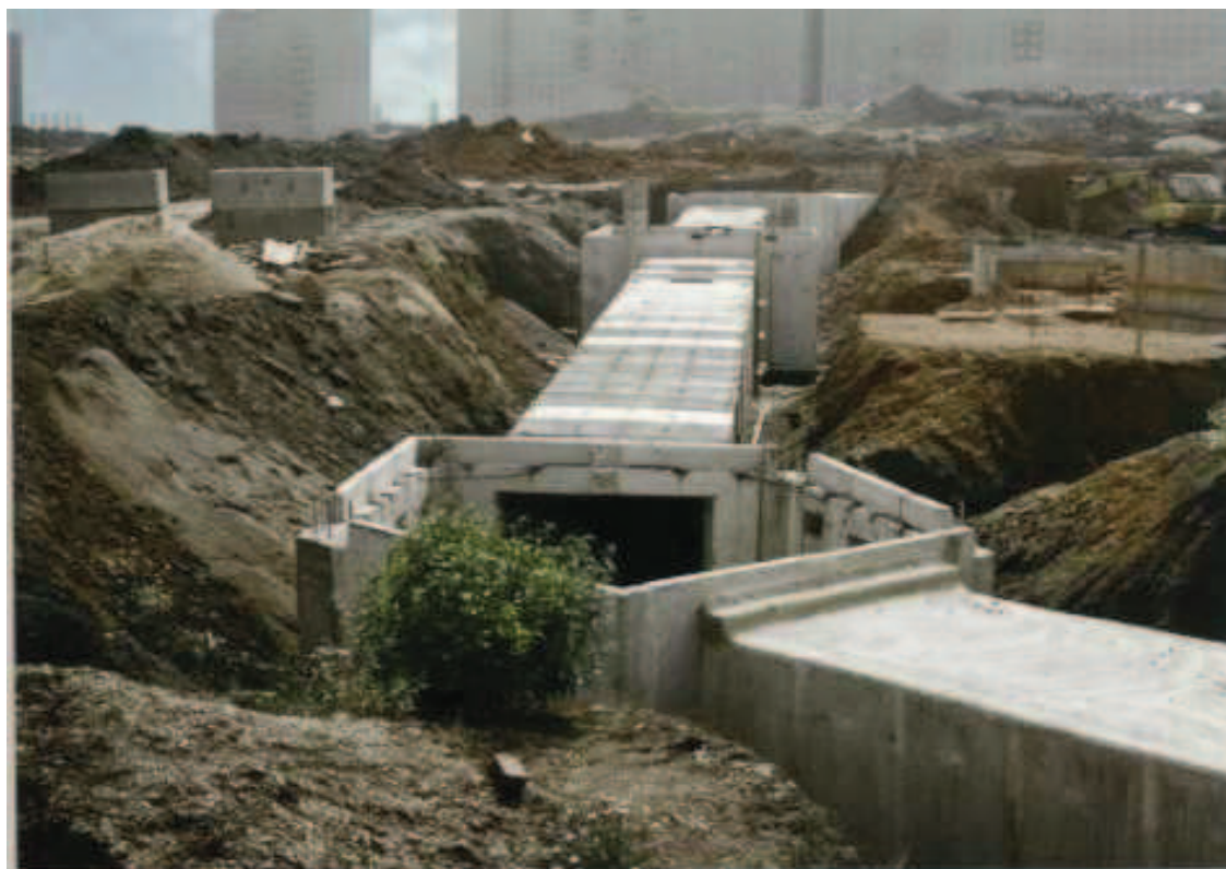
Obr. 1-1. Zahájení výstavby hloubených kolektorů Jihozápadní Město – Lužiny v roce 1987.
