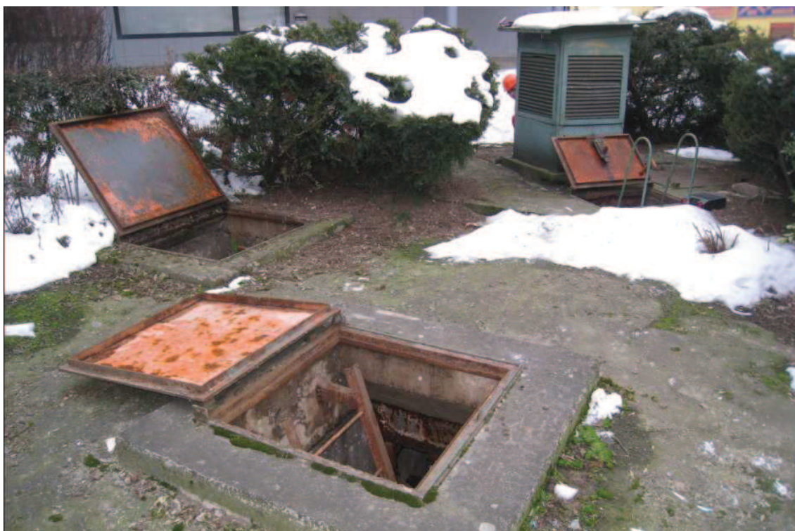
Obr. 2-8. Vstupní a úniková šachta VŠ3 na ulici Křenová. [13]
