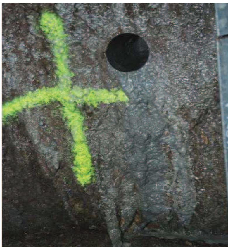
Obr. 4-5. Detail místa odběru jádrového vývrtu vzorku EII-16 (4.PP šachty Š3). [14]
