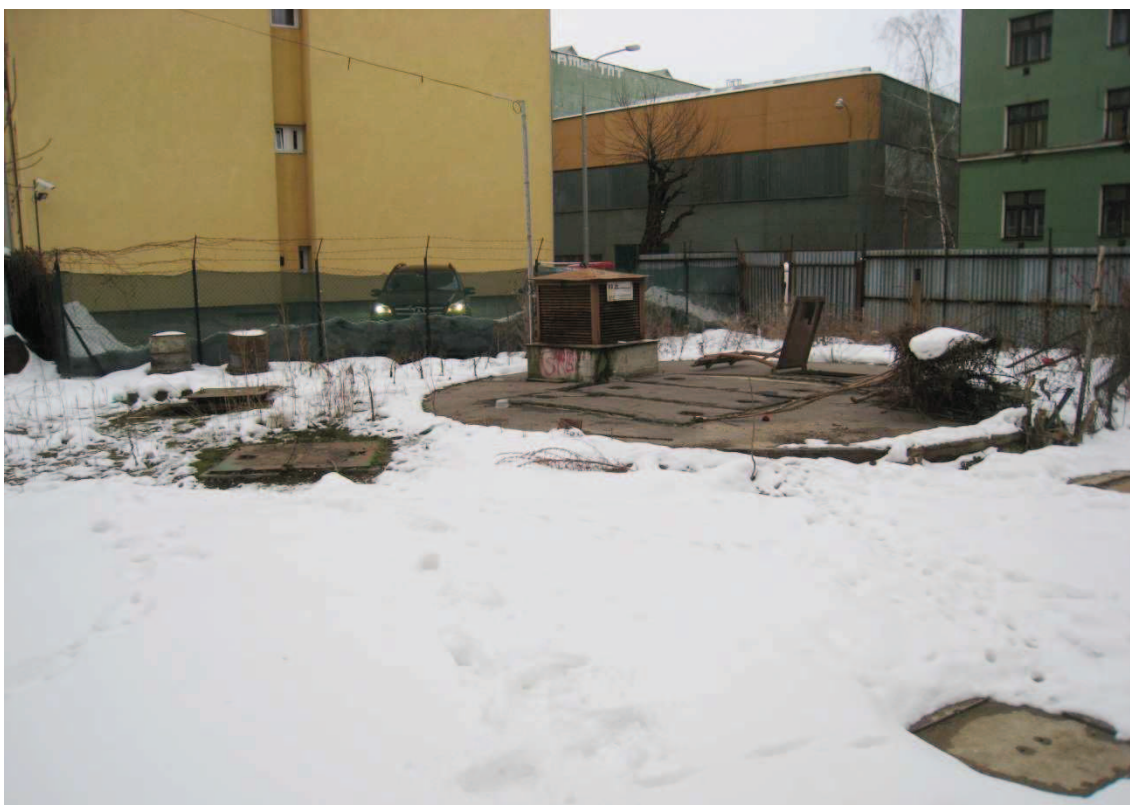
Obr. 2-9. Vstupní a větrací šachta Š3 na ulici Koželužská. [13]
