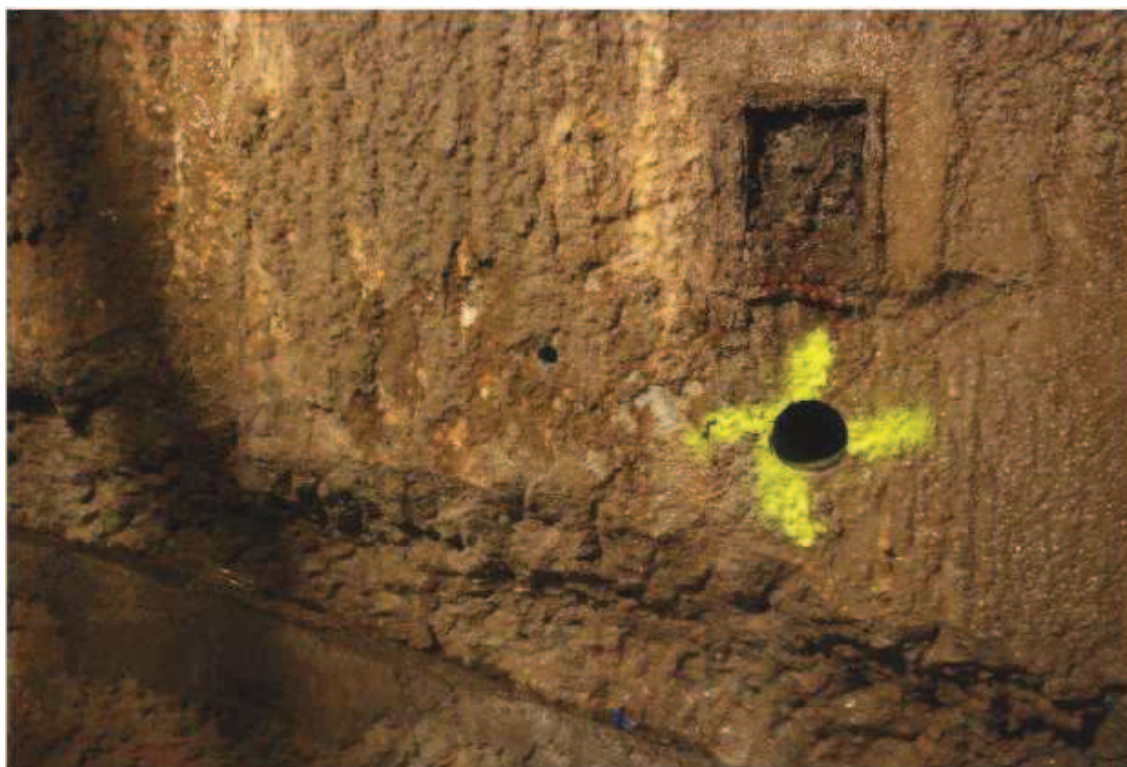
Obr. 4-8. Detail místa odběru jádrového vývrtu vzorku EII-16 (6. PP šachty Š3). [14]
