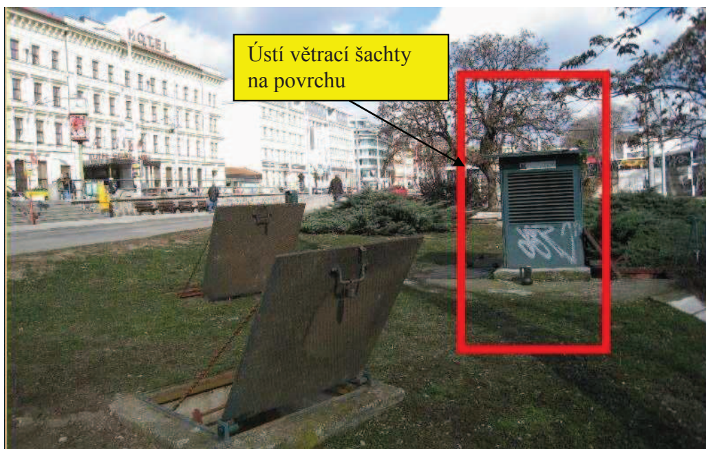
Obr. 2-11. Příklad vyústění větrací šachty na povrch u hotelu Grand v Brně. [13]
