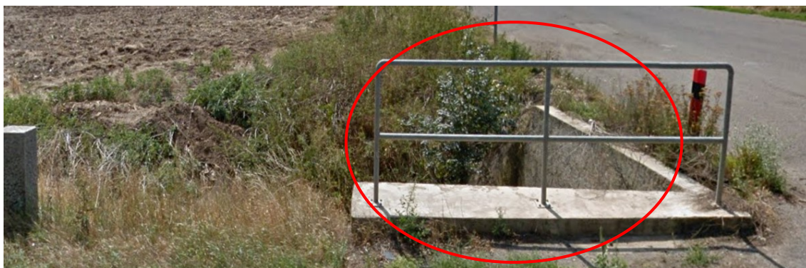
Obr. 3. 3 Propustek
