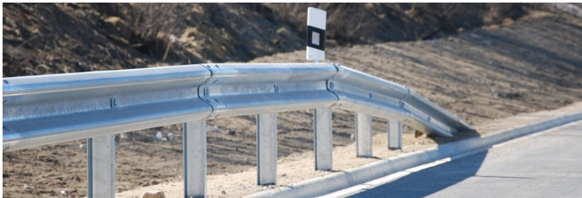
Obr. 4. 6 Svodidla
