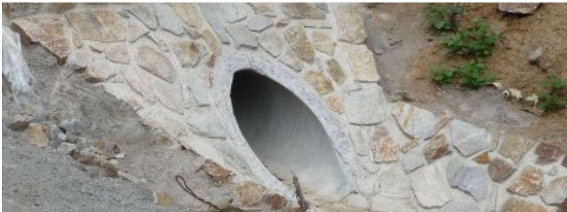
Obr. 4. 8 Propustek
