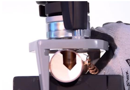
Obr. 8 Vrtání stěny trubky [19]
