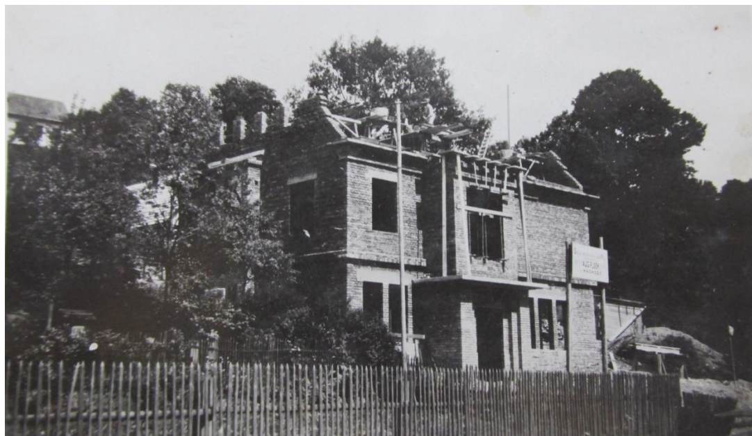
Ilustrace 5: Budova nové školy ve výstavbě
