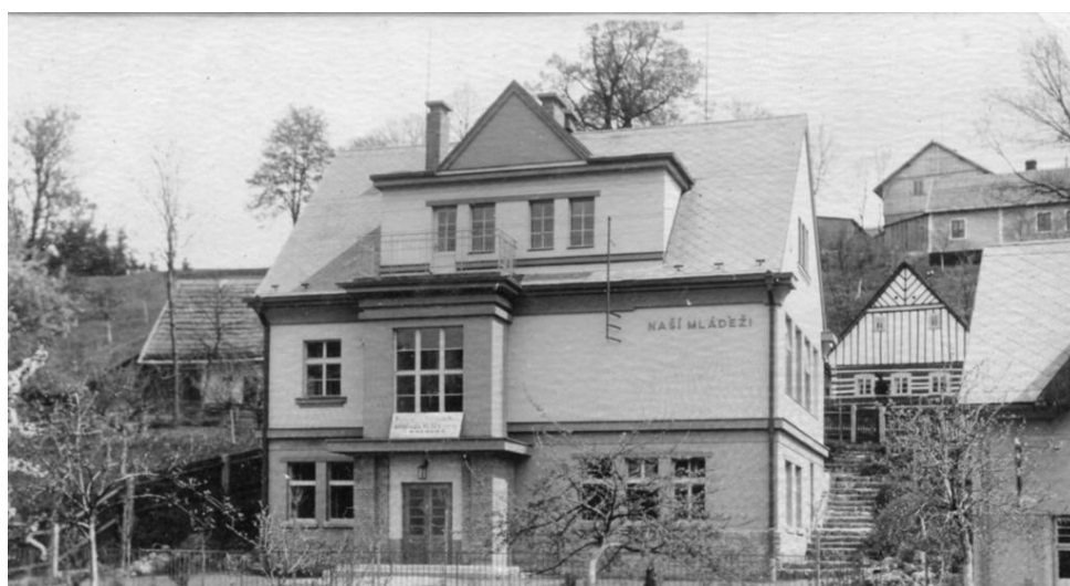
Ilustrace 6: Budova nové školy po dokončení
