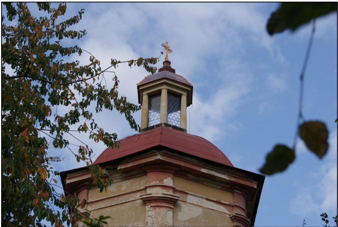
Obr. 28: Kaple sv. Andělů strážných s detailem na opravenou střechu
