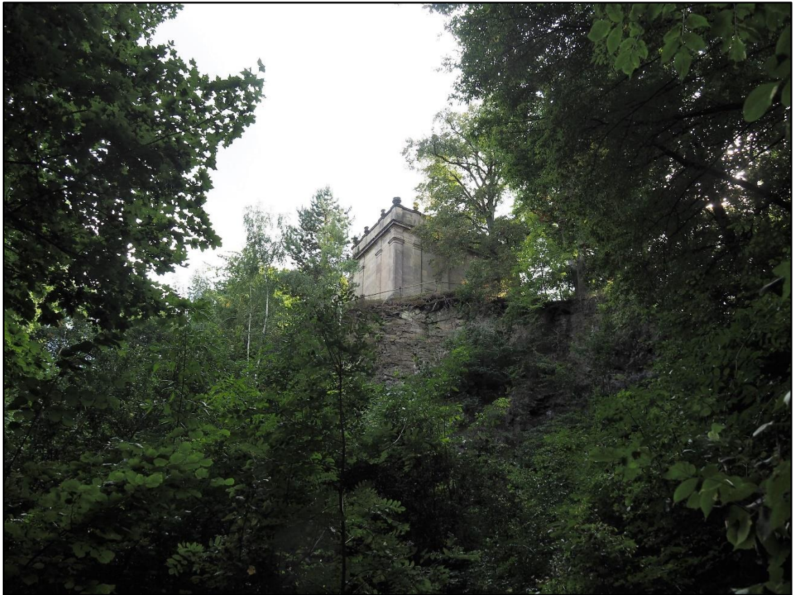
Obr. 25: Loreta z pohledu zezdola z bývalého lomu, září 2021
