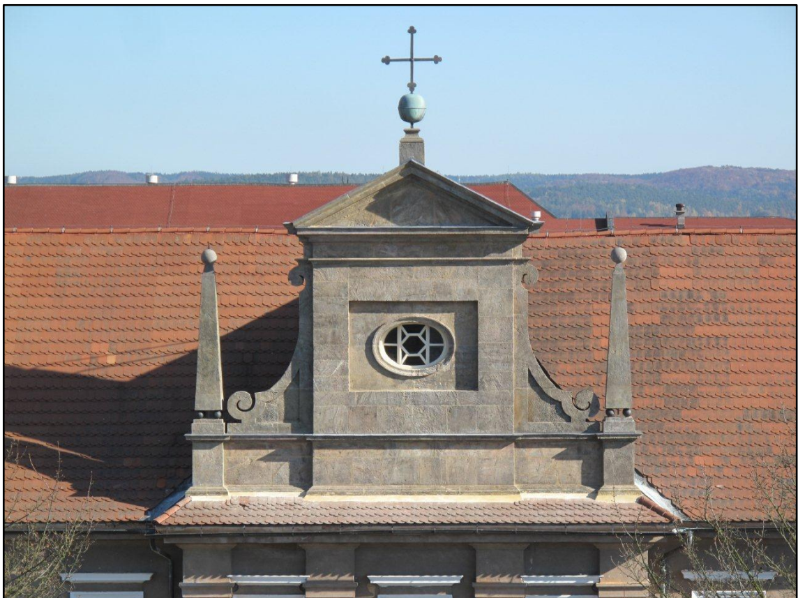
Obr. 22: Detail opraveného průčelí kostela sv. Josefa
