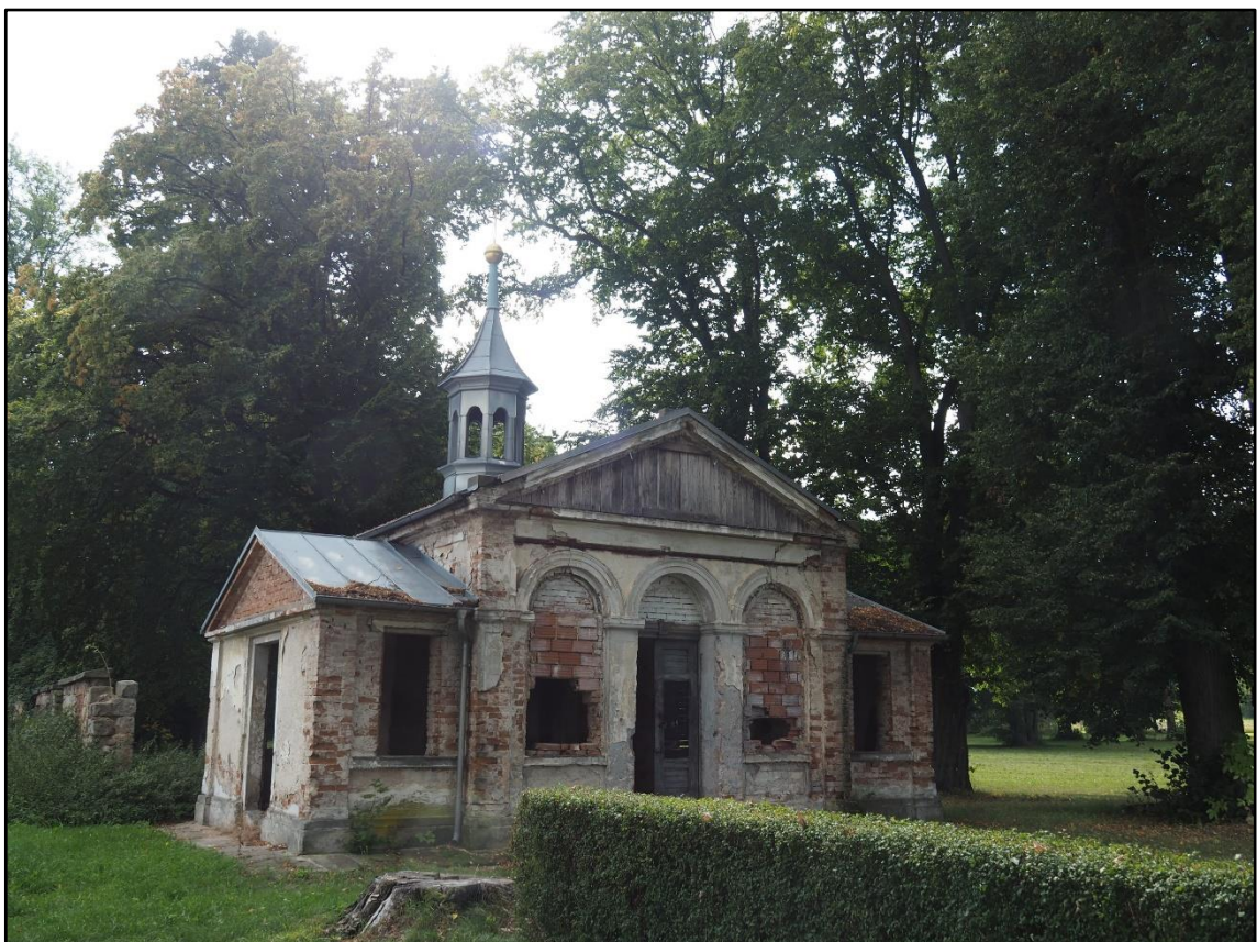
Obr. 31: Kaple v arálu zámku ve Vokšicích, září 2021
