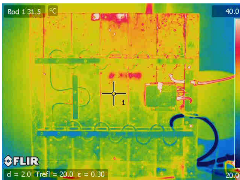
Obr. 2-58 Termosnímek svítidla vybaveného světelnými diodami.
