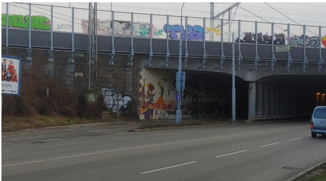
Obrázok 6. Podjazd pod železničným viaduktom na ul. Karlova.
