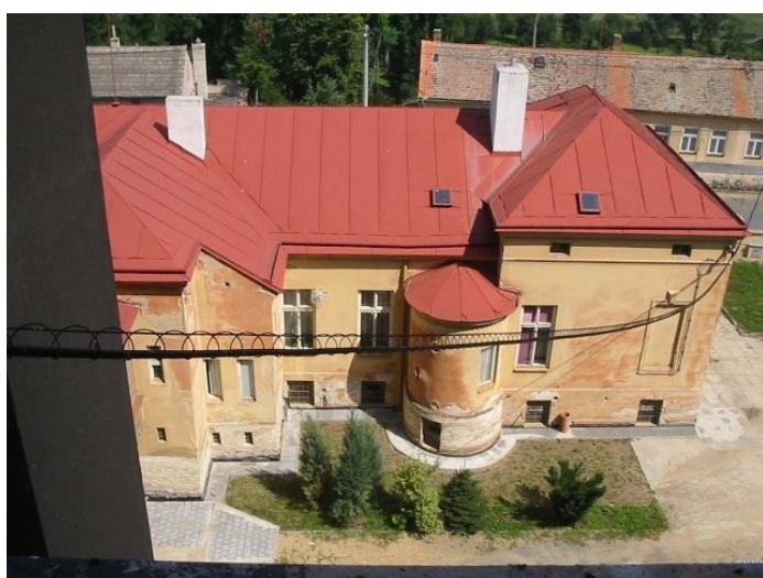
Zařízení, pohled do silnice
