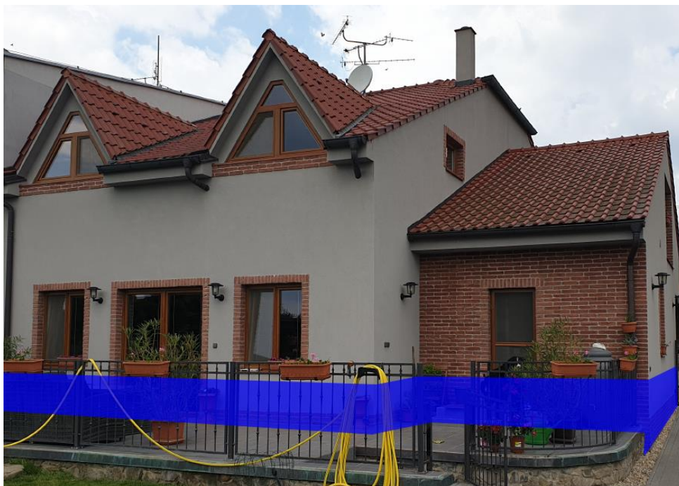
Obrázek 5: Zadní část domu výška hladiny vody
