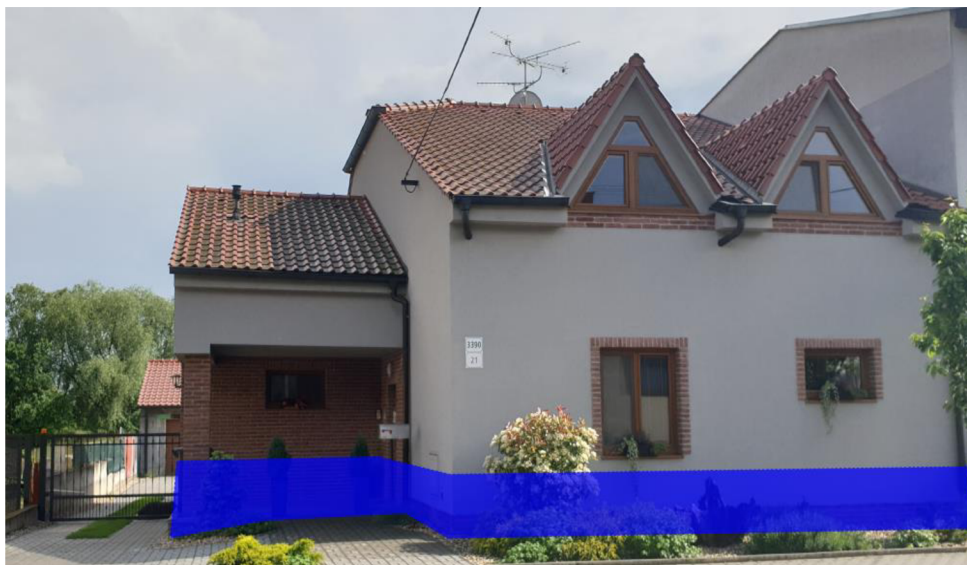
Obrázek 4: Přední část domu výška hladiny vody
