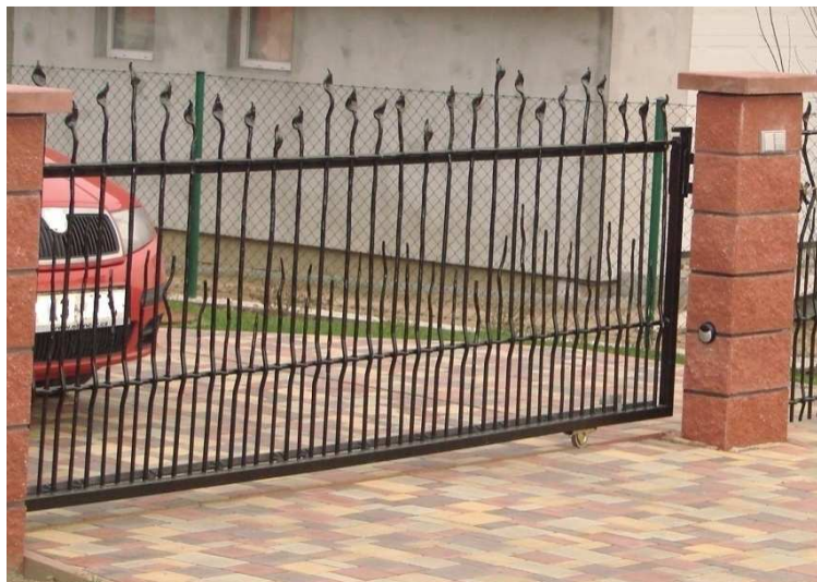
Obr. 2 Brána s bočním posuvem na kolejnici.
