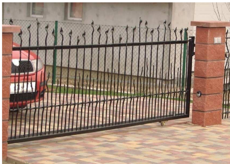
Obr. 2 Brána s bočním posuvem na kolejnici.
