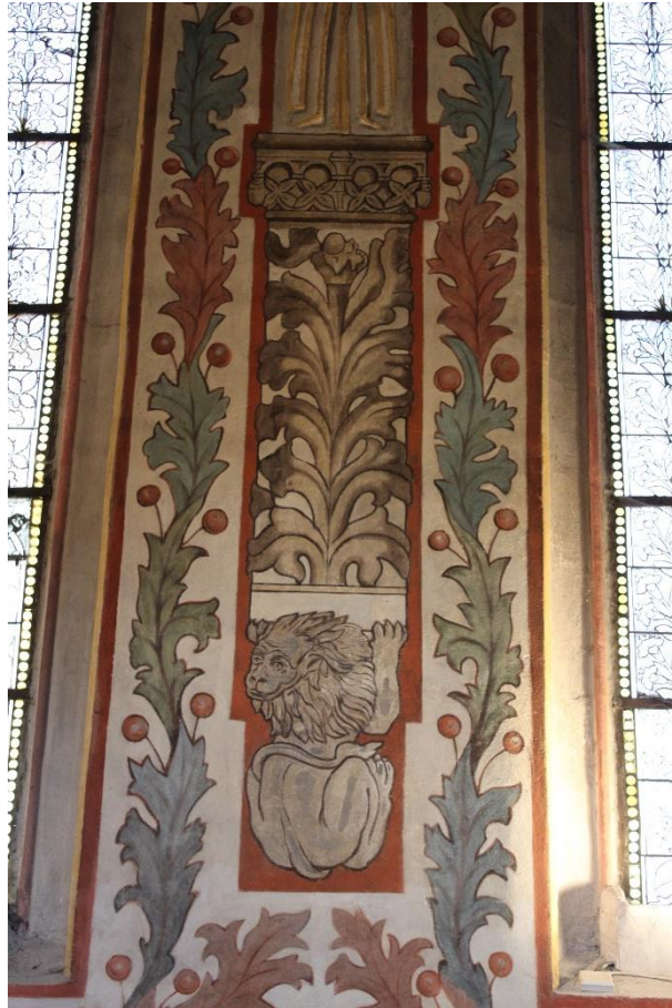
Obr. 25 malířská výzdoba, severní stěna, detail – iluzivní konzole
