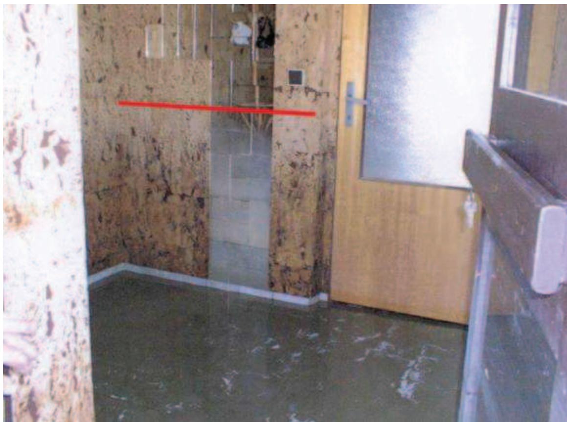
Interiér – 1NP, Zádveří, červená linka zobrazuje nejvyšší vodní stav v srpnu 2002.
