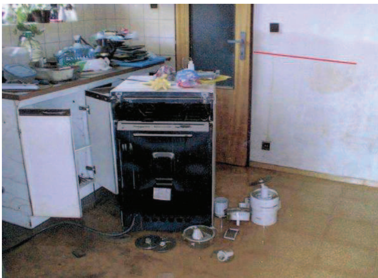
Interiér – 1NP, Kuchyň, červená linka zobrazuje nejvyšší vodní stav v srpnu 2002.
