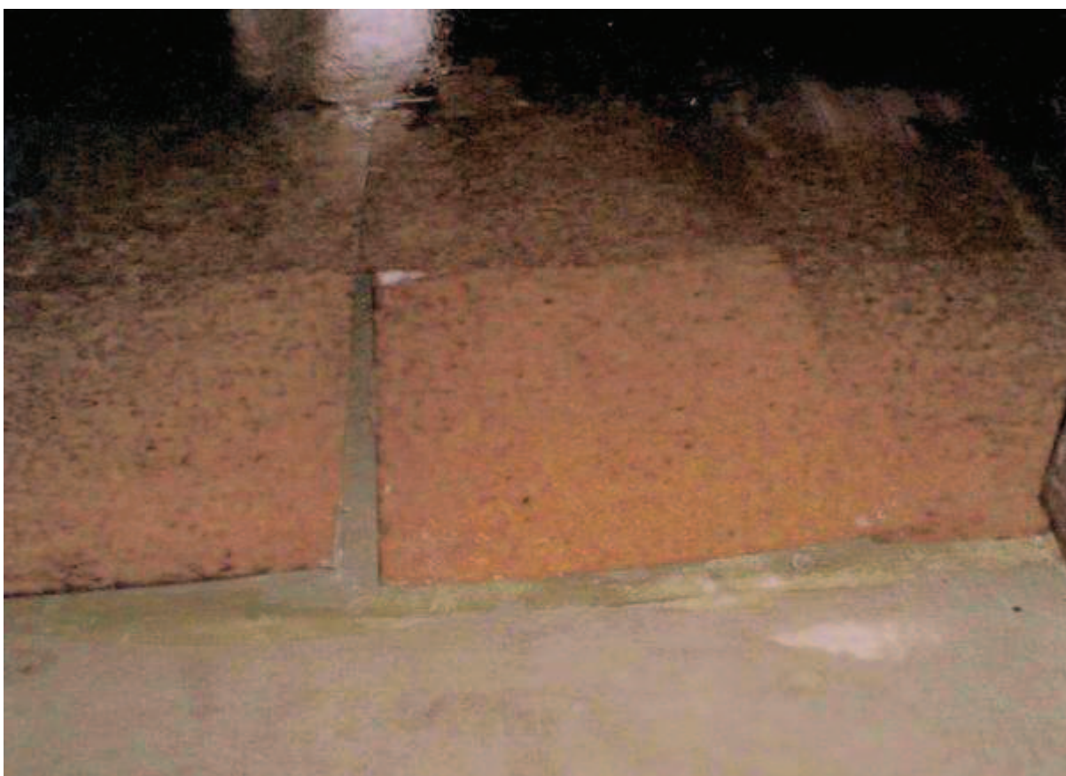
Interiér – 1NP, Hala – Uvolněné korkové dílce.
