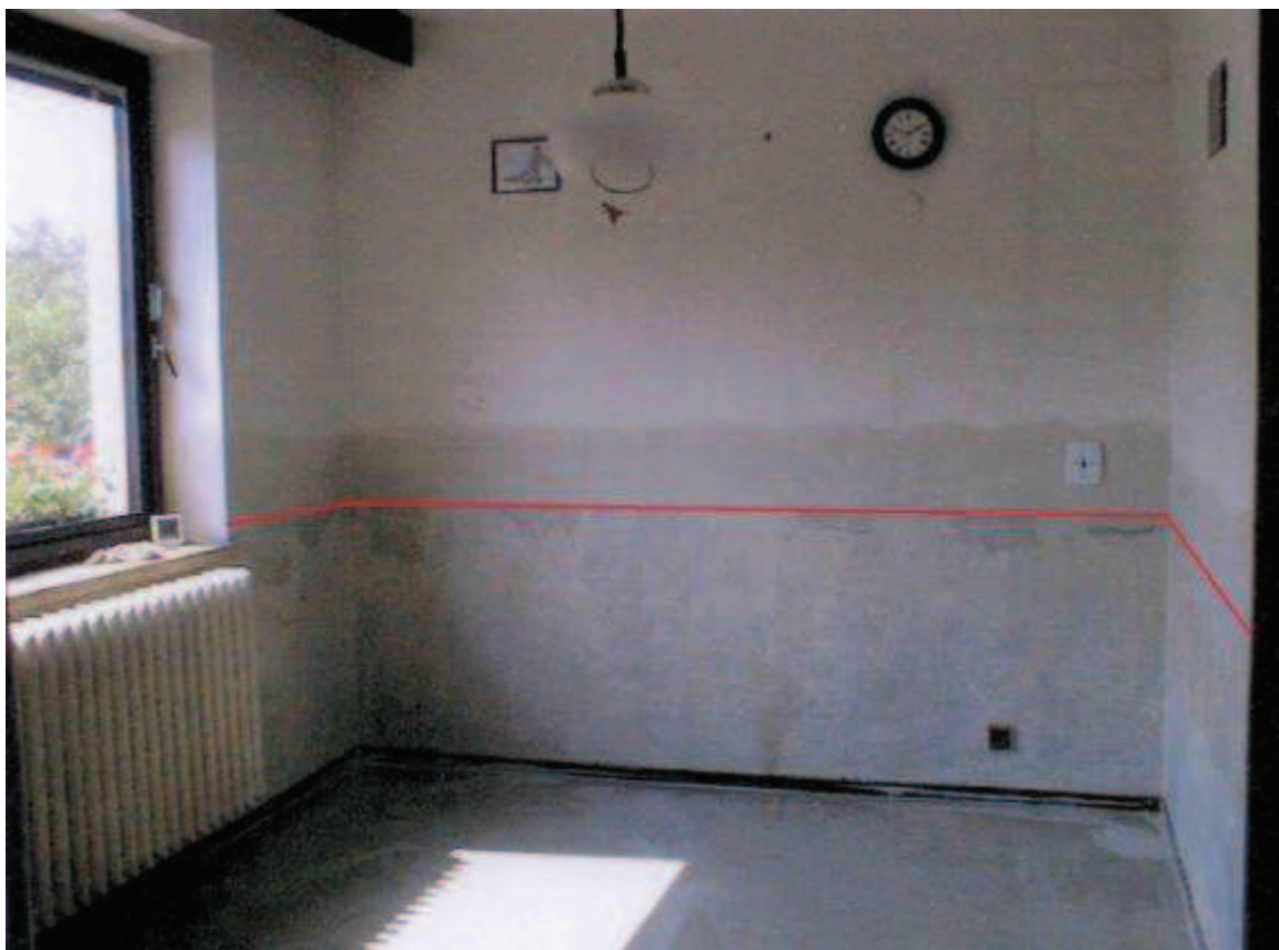
Interiér – 1NP, Jídelna, červená linka zobrazuje nejvyšší vodní stav v srpnu 2002
