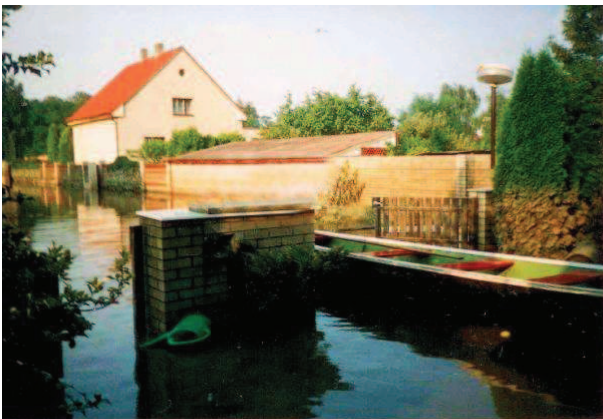
Pohled od vchodu posuzovaného objektu do ulice Šmeralova.
