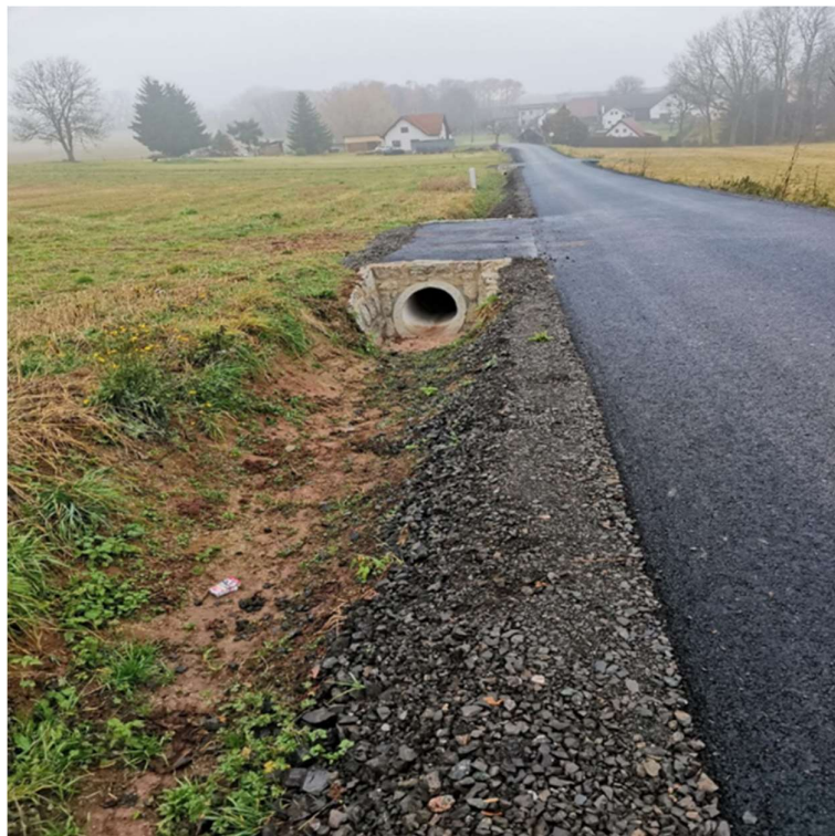
Obrázek 4: Propustek k.ú. Lomnice nad Popelkou (autorka ©2021).
