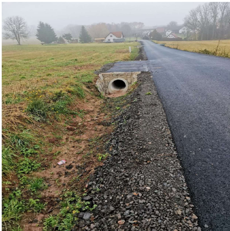
Obrázek 4: Propustek k.ú. Lomnice nad Popelkou (autorka ©2021).
