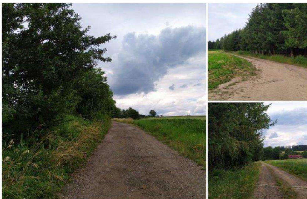
Obrázek 19: HC7-R – Polní cesta před rekonstrukcí.
