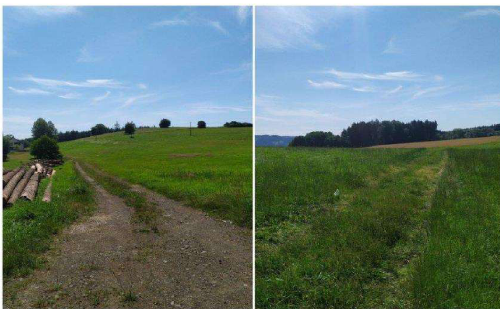
Obrázek 20: VC42-R - Polní cesta před rekonstrukcí.
