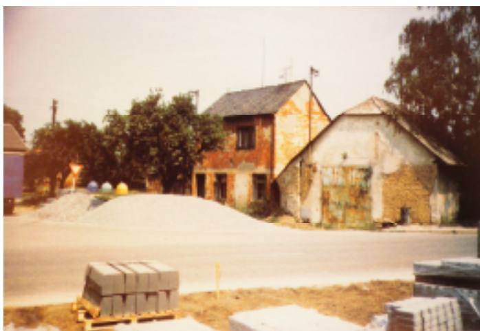
Obr. č. 15: Hasičská zbrojnice před obecním úřadem v 90. letech minulého století (zdroj: Pamětní kniha obce Lutín 1975-1998)
