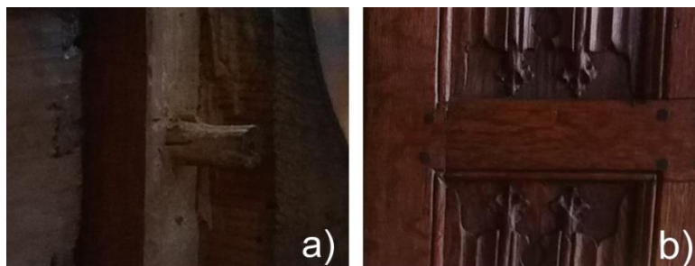
Obrázek 3: Příklad užití kolíčkového spoje
