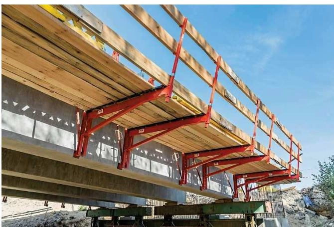
Obrázek 5-1 Lávka na žel. mostě
