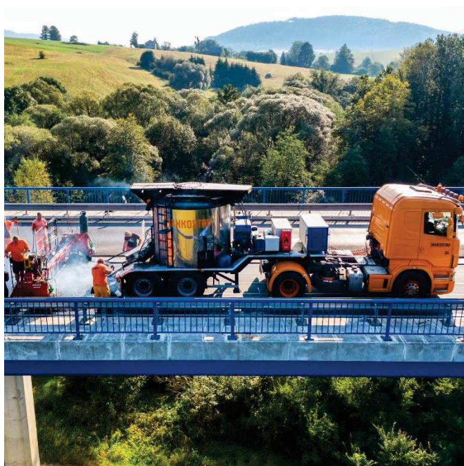
Obrázek 6-19 Souprava na pokládku litého asfaltu
