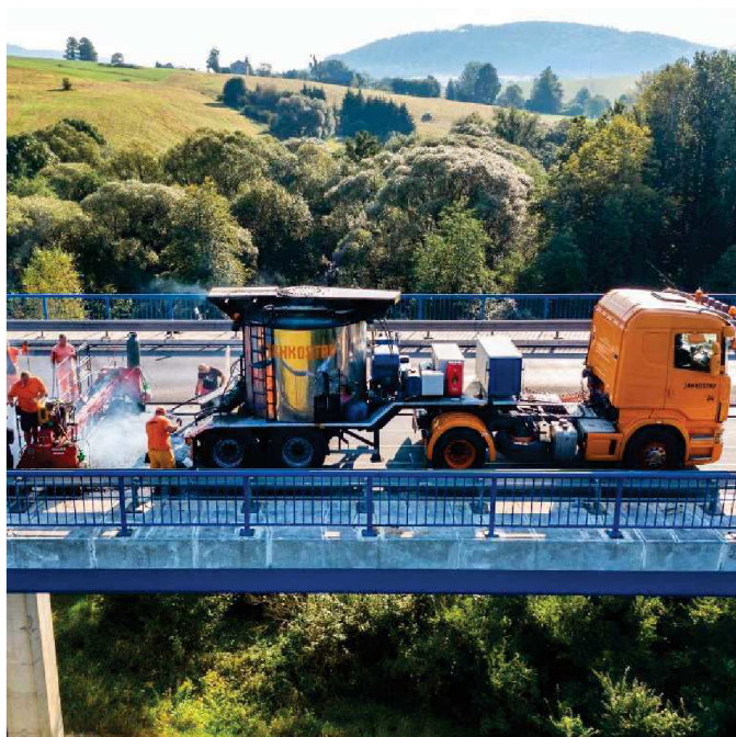
Obrázek 6-19 Souprava na pokládku litého asfaltu
