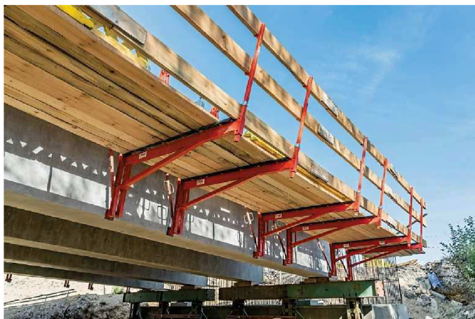
Obrázek 5-1 Lávka na žel. mostě
