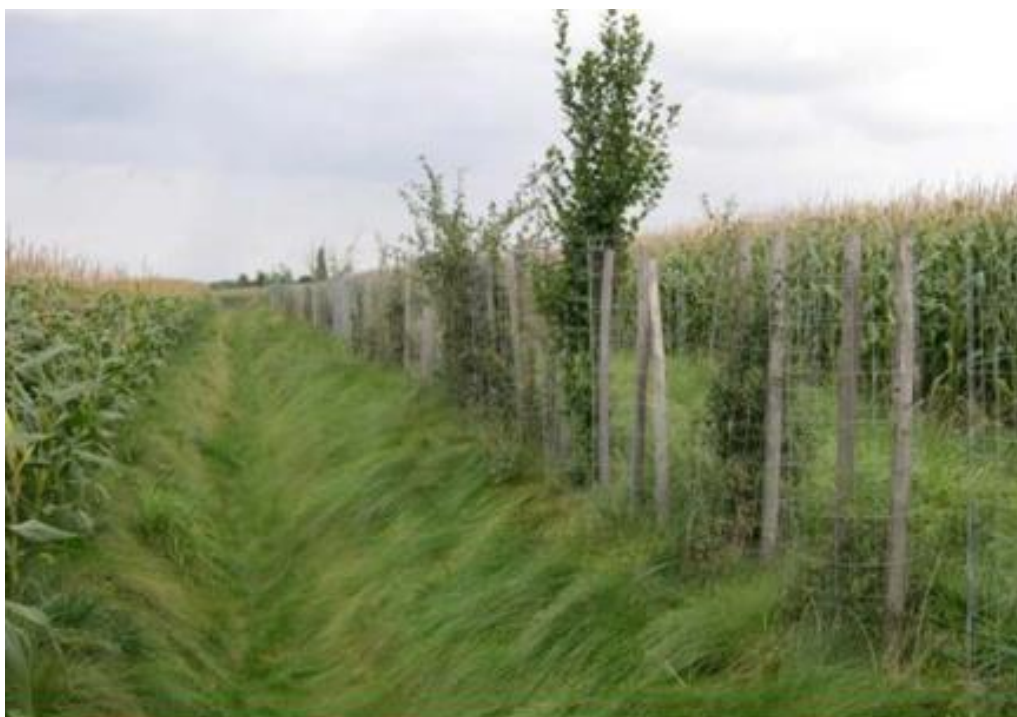
Obr. č. 9 - Protierozní mez s příkopem (Heroltice u Tišnova, foto VÚMOP, v.v.i.).
