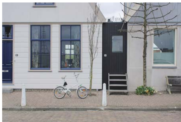
Obr. 104. Jednoduchá prístavba s čiernym dreveným obkladom vytvorila prípustnú formu dvojdomu v obci Durgerdam. Severné Holandsko - NL (foto: Milan Šuška)
