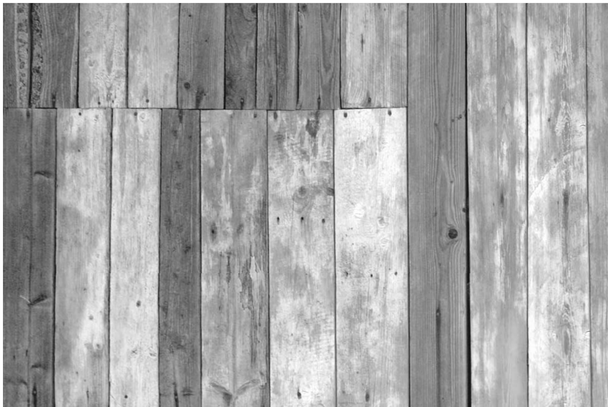
Obr. 84. Znovupoužitý materiál. Štruktúra vznikla nedbanlivým poskládaním dosiek, ktoré boli predtým z vnútornej strany natreté vápnom a z vonkajšej olejom. Kolokočov - Kornica (foto: Milan Šuška)
