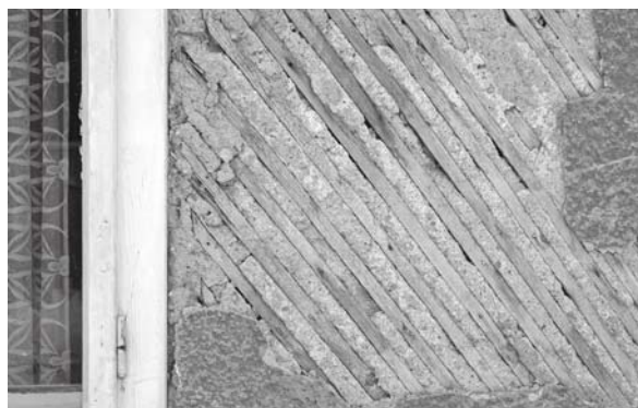
Obr. 88. Omietka na drevenom rošte. Stará Bystrica (foto: Milan Šuška)
