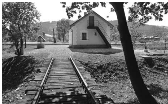
Obr. 45. Pamätná izba Rodný dom Jozefa Kronera. Staškov, autor: Ing. Šimčisko, Ing. Kubošek, Ing. Machovčák, Ing. Gajdošík. (foto: Milan Šuška)
