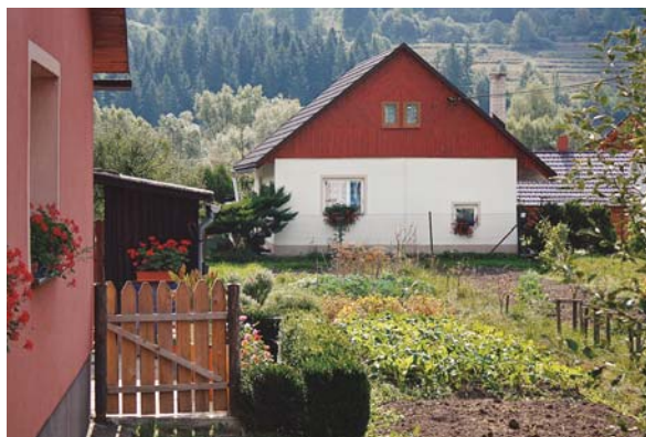
Obr. 60. Na štíte originálna drevená štruktúra s červeným náterom a neutrálna biela omietka. Staškov (foto: Milan Šuška)
