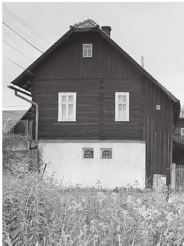
Obr. 87. Tehlový pás vyrovnáva podmúrovku a vlhkosť medzi rôznymi materiálmi. Vysoká nad Kysucou (foto: Milan Šuška)
