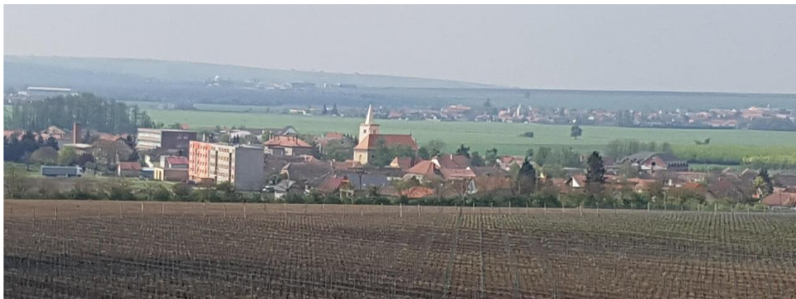
Obr. 3 Pohled na Vrbovec z viniční tratě Waldberk
