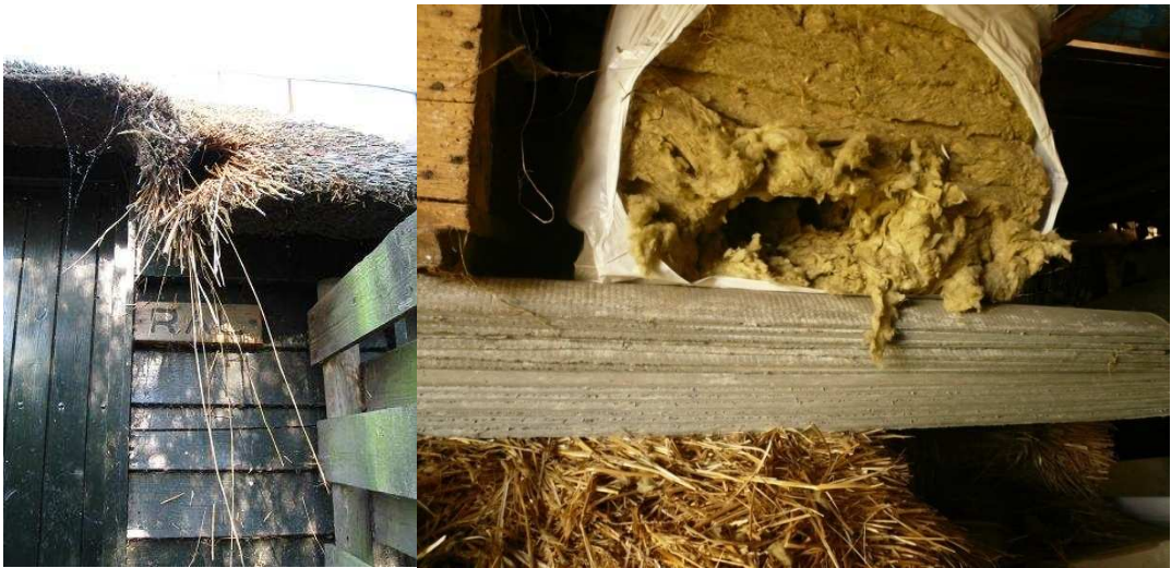
Obr. č. 15 Doupata kuny skalní, zleva ve slaměné střeše, v balíku skelné vaty
