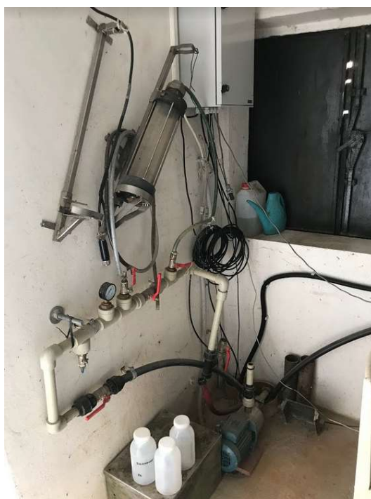
Obr. 18. V minulosti využívaný systém odběru vzorků suspendovaných látek v Židlochovicích
