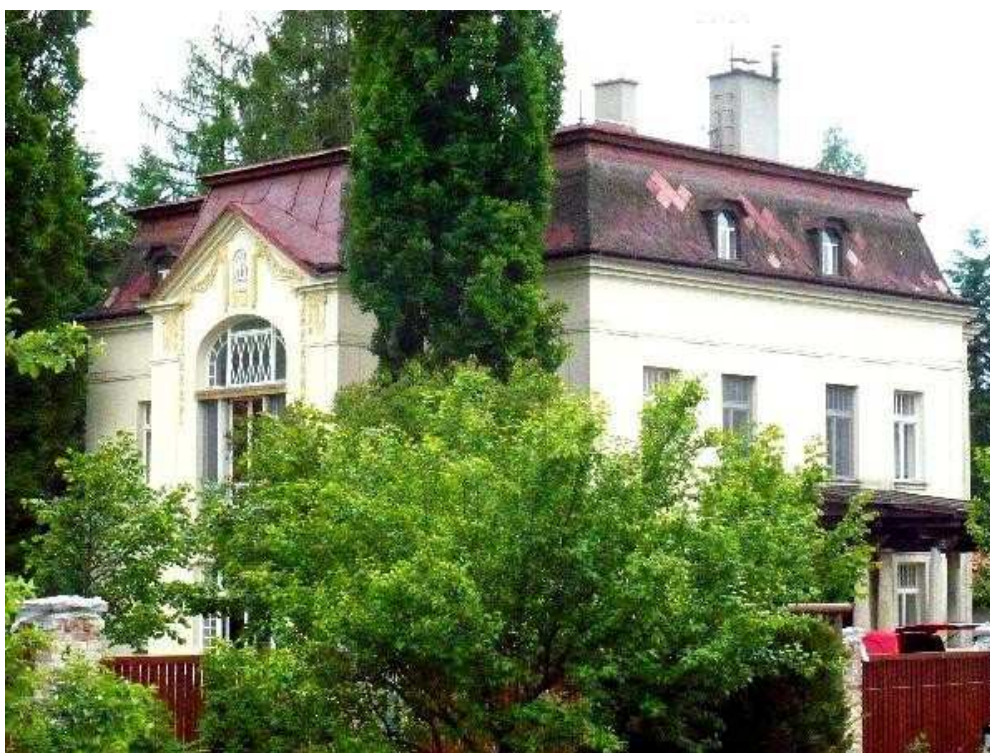
19. Pohled od severovýchodu na hlavní vstup, 2012.
