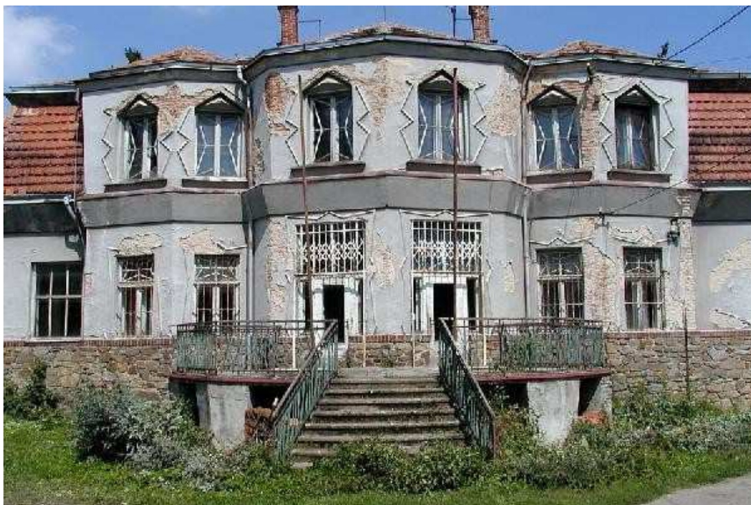
62. Jižní průčelí před rekonstrukcí, 2003.
