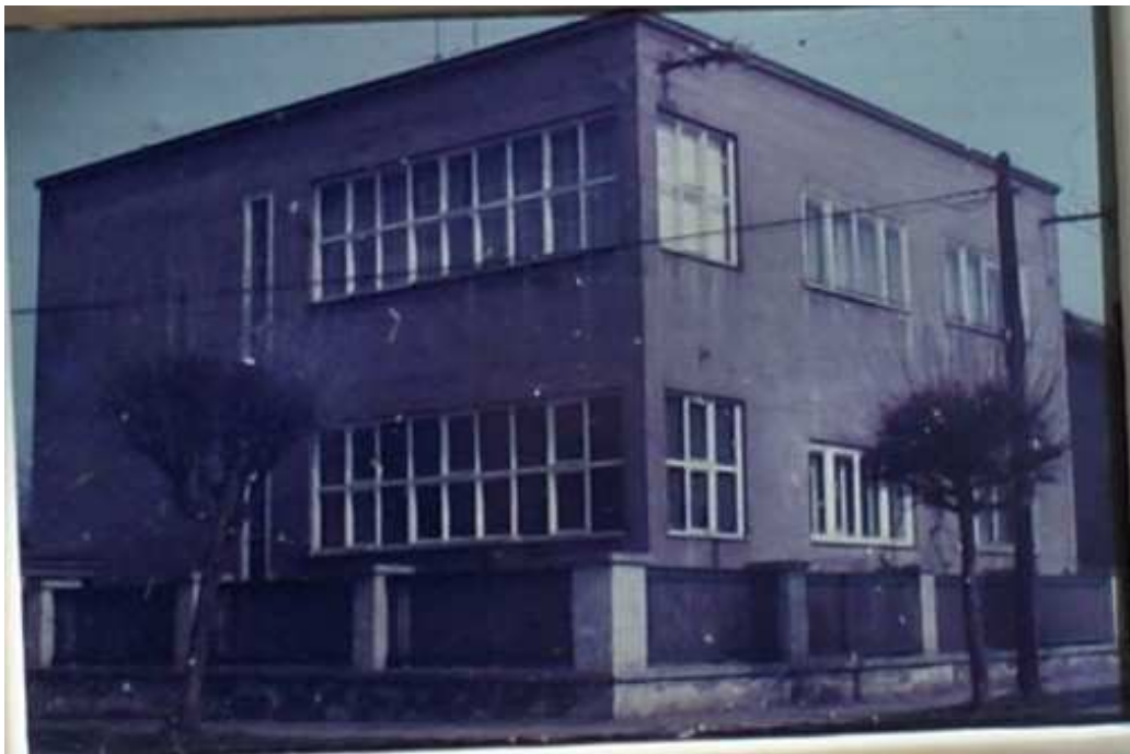
182. Původní okna, nedatovaná fotografie domu na diapositivu.
