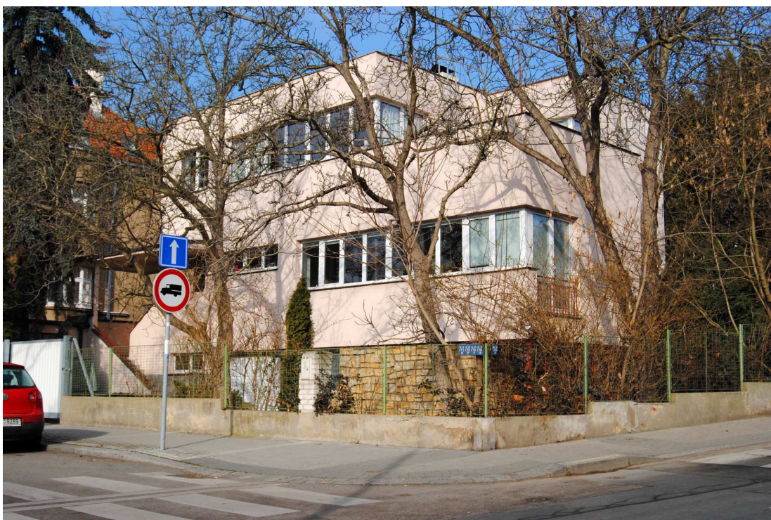
247. Pohled od jihovýchodu, 2014.
