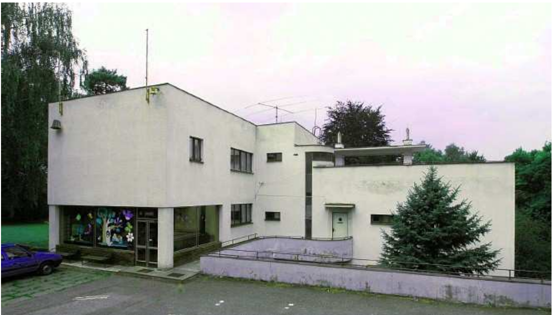
161. Pohled od východu, 2007.
