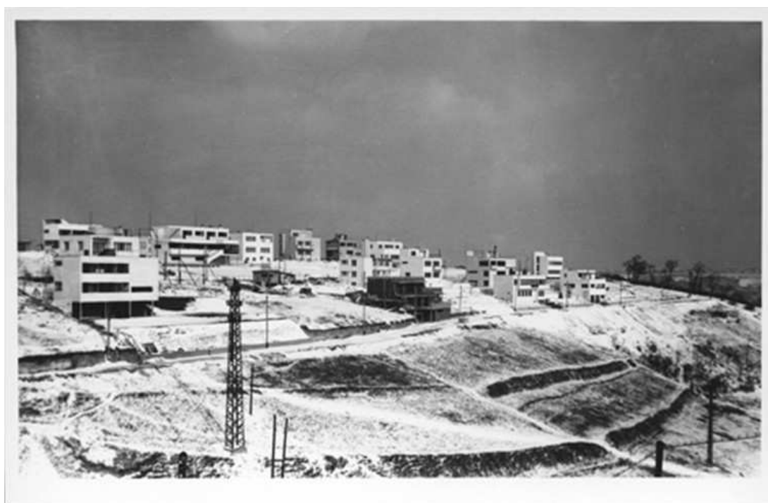
217. Kolonie Baba ve výstavbě (v popředí s rozestavěnou Kytlicovou vilou), 1933.
