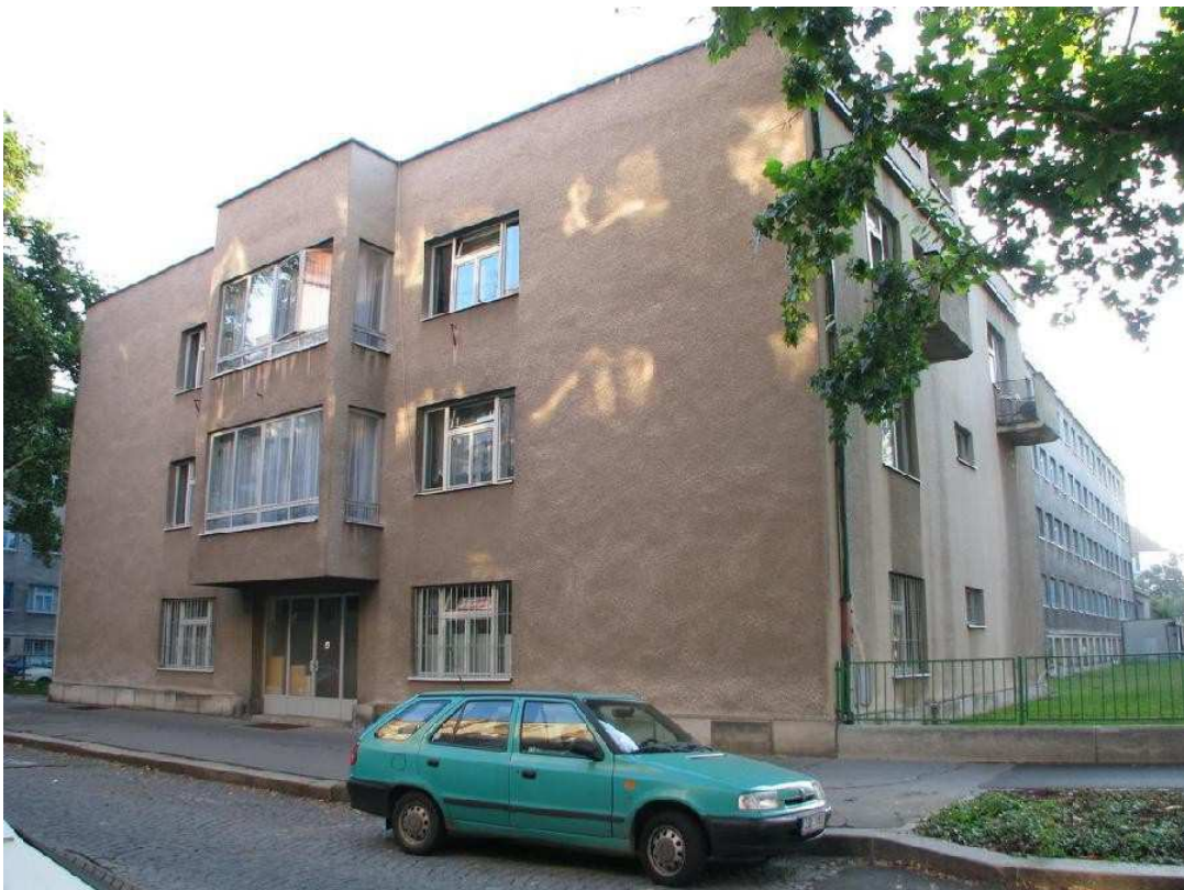
147. Pohled od jihozápadu na hlavní uliční vchod (z Mánesovy ulice), 2011.
