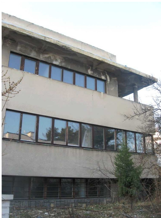
260. Stav fasády před rekonstrukcí, 2012.
