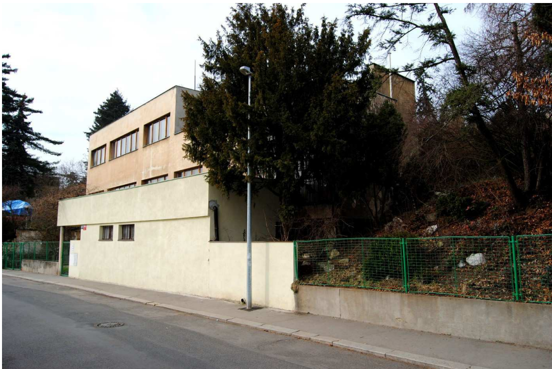
211. Pohled od jihovýchodu (z ulice Nad Pařankou), 2014.
