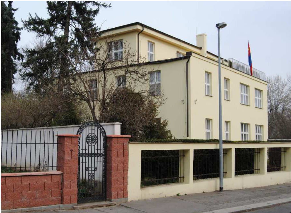
125. Jihozápadní nároží po přístavbě, 2014.
