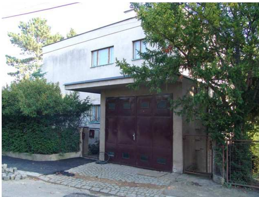
284. Vstupní průčelí před rekonstrukcí, 2005.
