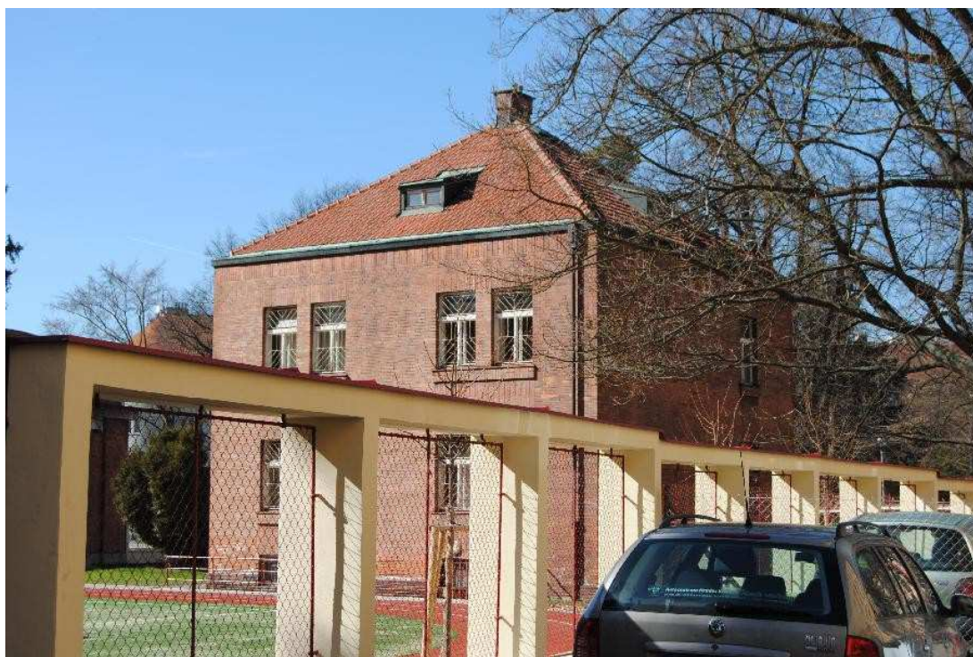
140. Pohled na jihovýchodní průčelí, 2014.
