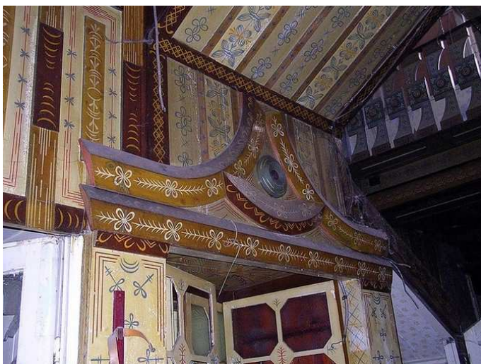
72., 73., 74. Dřevěné dekorované obložení ve schodišťové síni (výzdoba František Kysela), stav před demolicí, 2008.
