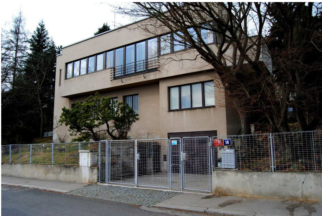
196. Pohled z ulice Nad Paťankou, 2014.
