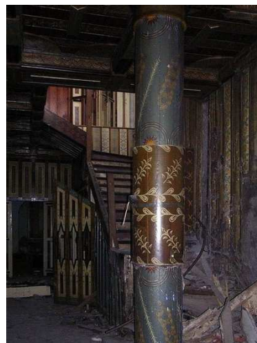
78. Dřevěné dekorované obložení ve schodišťové síni (výzdoba František Kysela), stav před demolicí, 2008.
