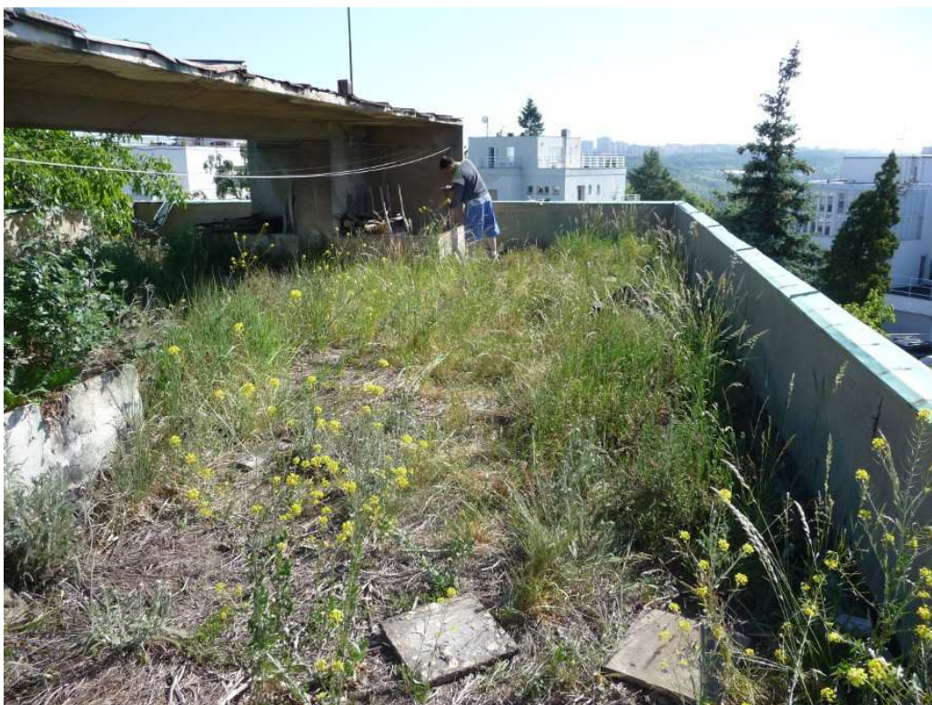
258. Stav střechy před rekonstrukcí, 2010.
