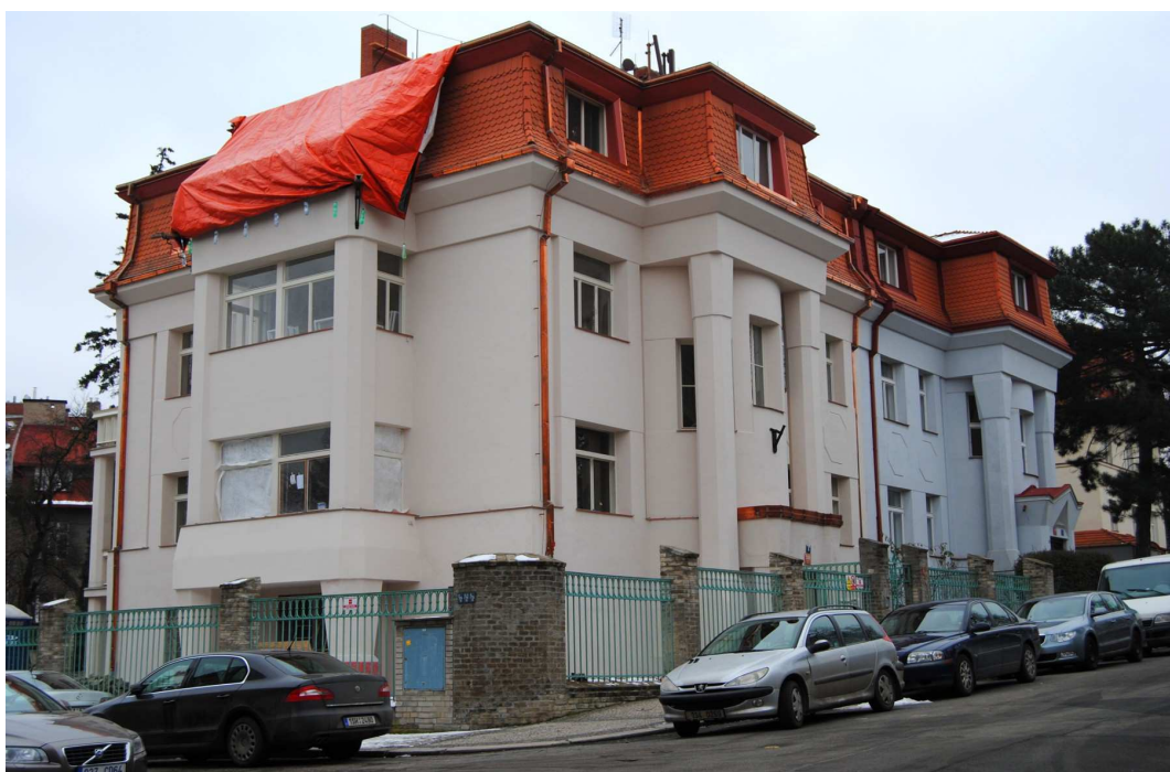
29. Přední průčelí dvojvily (z ulice Tychonova) v průběhu rekonstrukce vily čp. 268, 2014.
