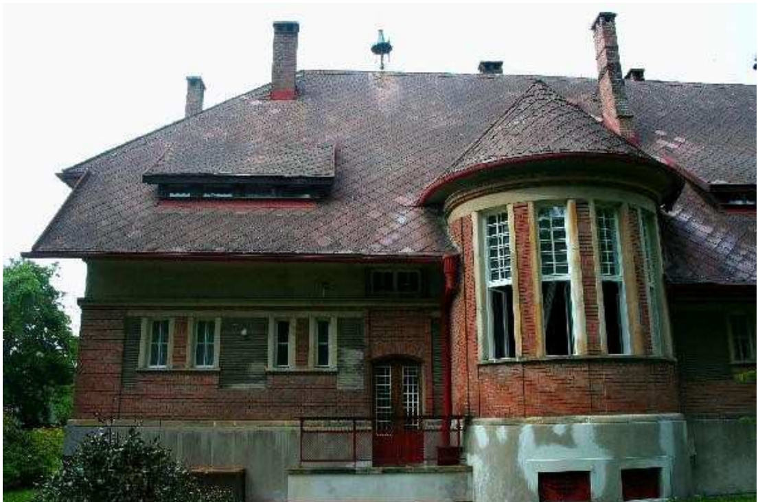
4. Arkýř jižního průčelí s vedlejším zahradním vstupem, 2012.
