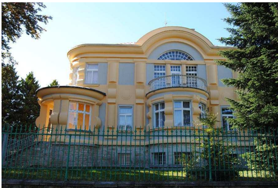
93. Hlavní průčelí (z Nerudovy ulice), 2013.
