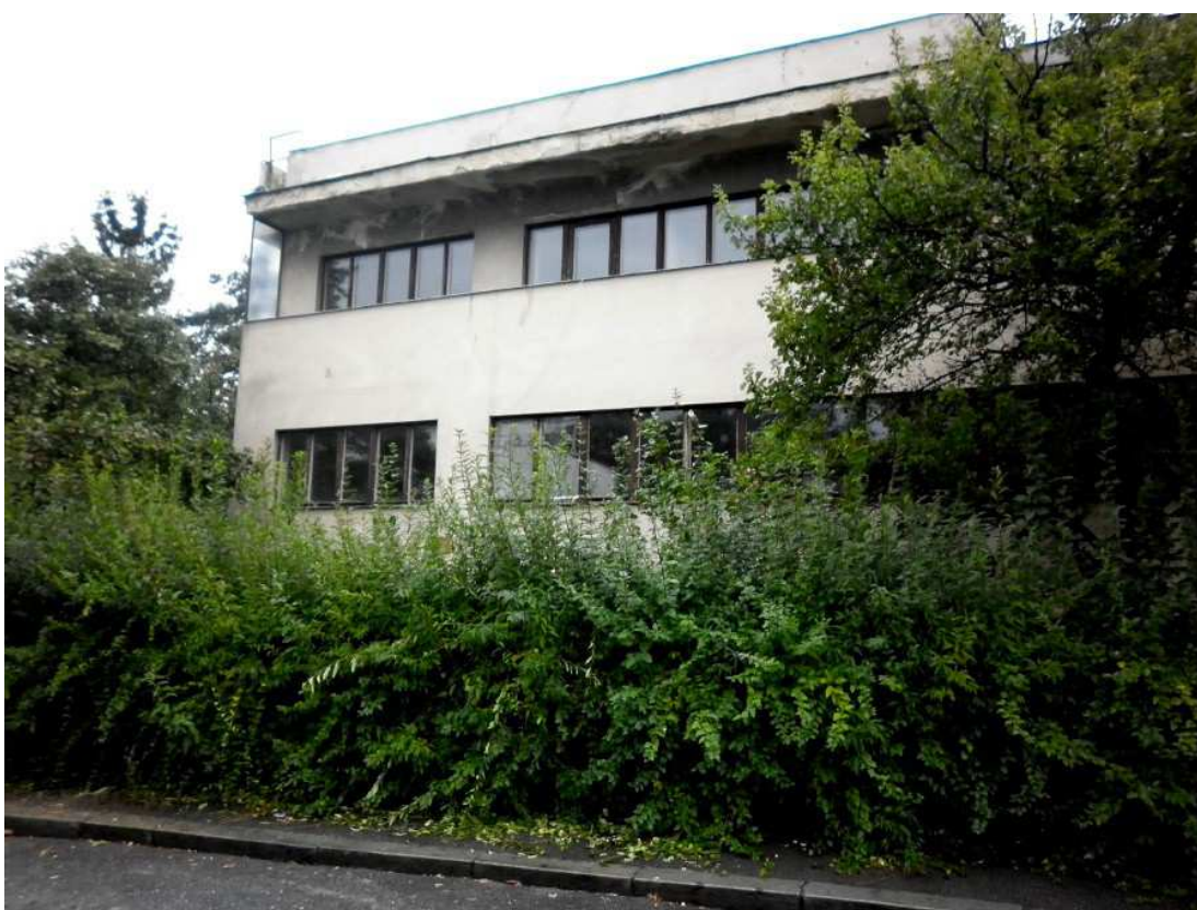
257. Stav jižního průčelí před rekonstrukcí, 2010.
