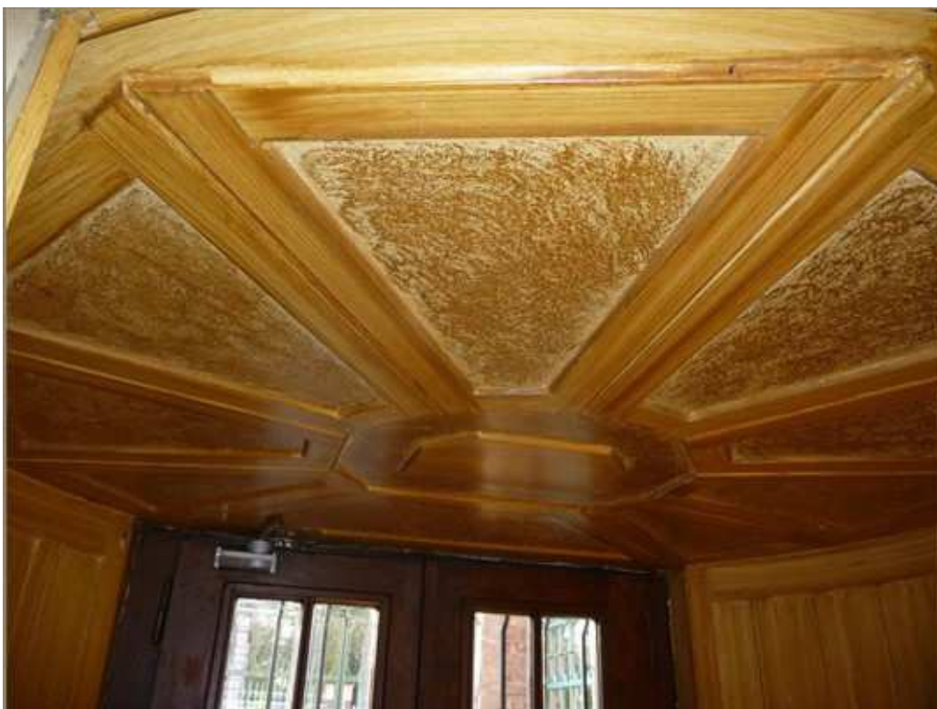
47. Strop interiéru vstupní části vily čp. 268, 2012.
