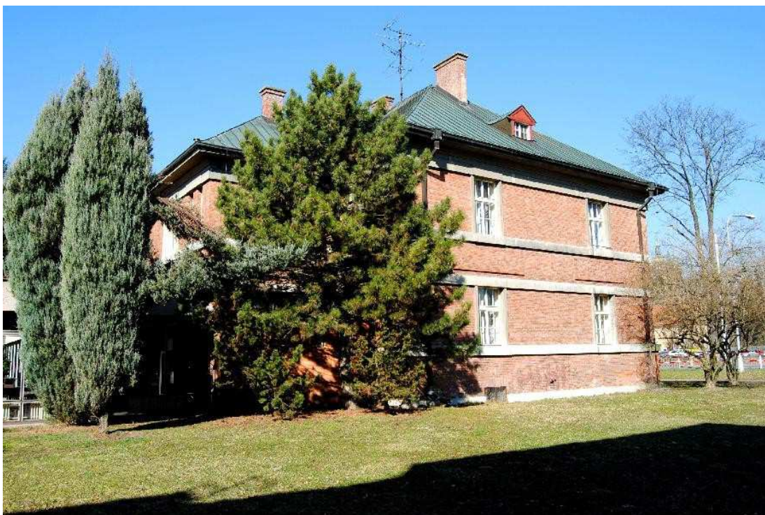
109. Pohled od východu, 2014.
