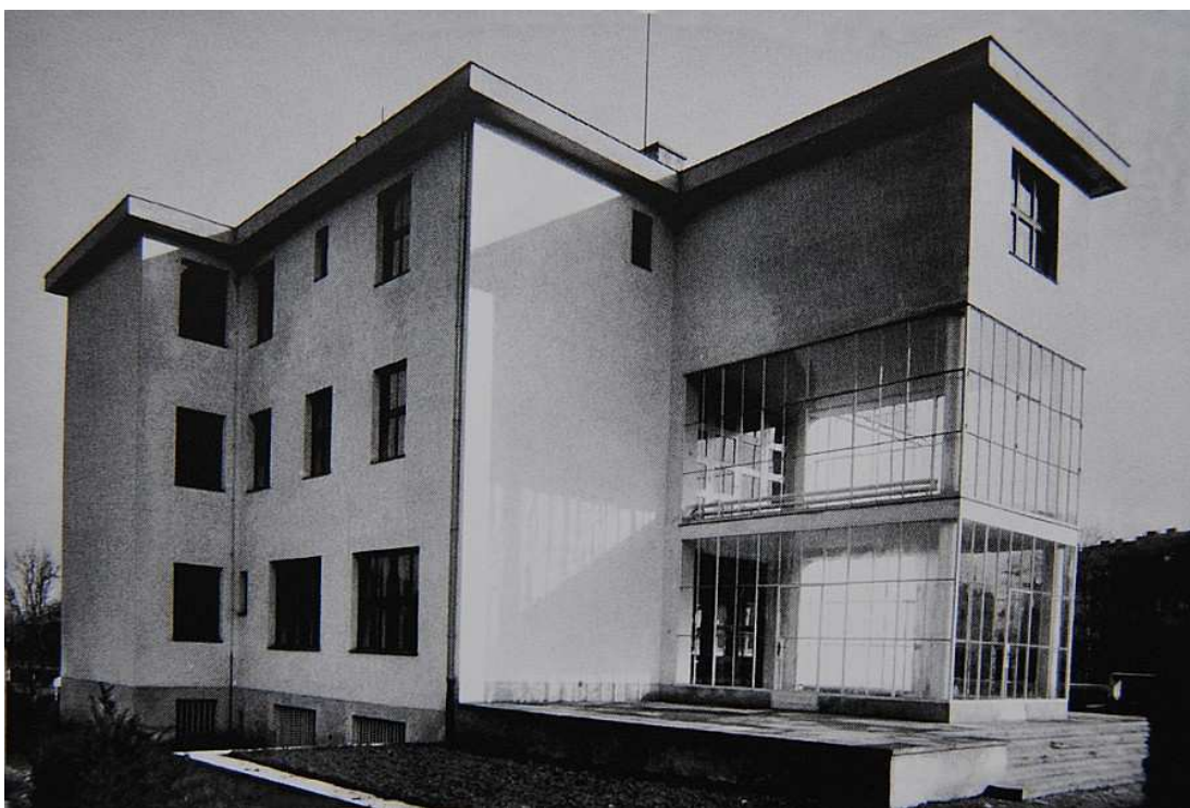
129. Pohled od západu na křídlo s prosklenou zimní zahradou, dobová fotografie.
