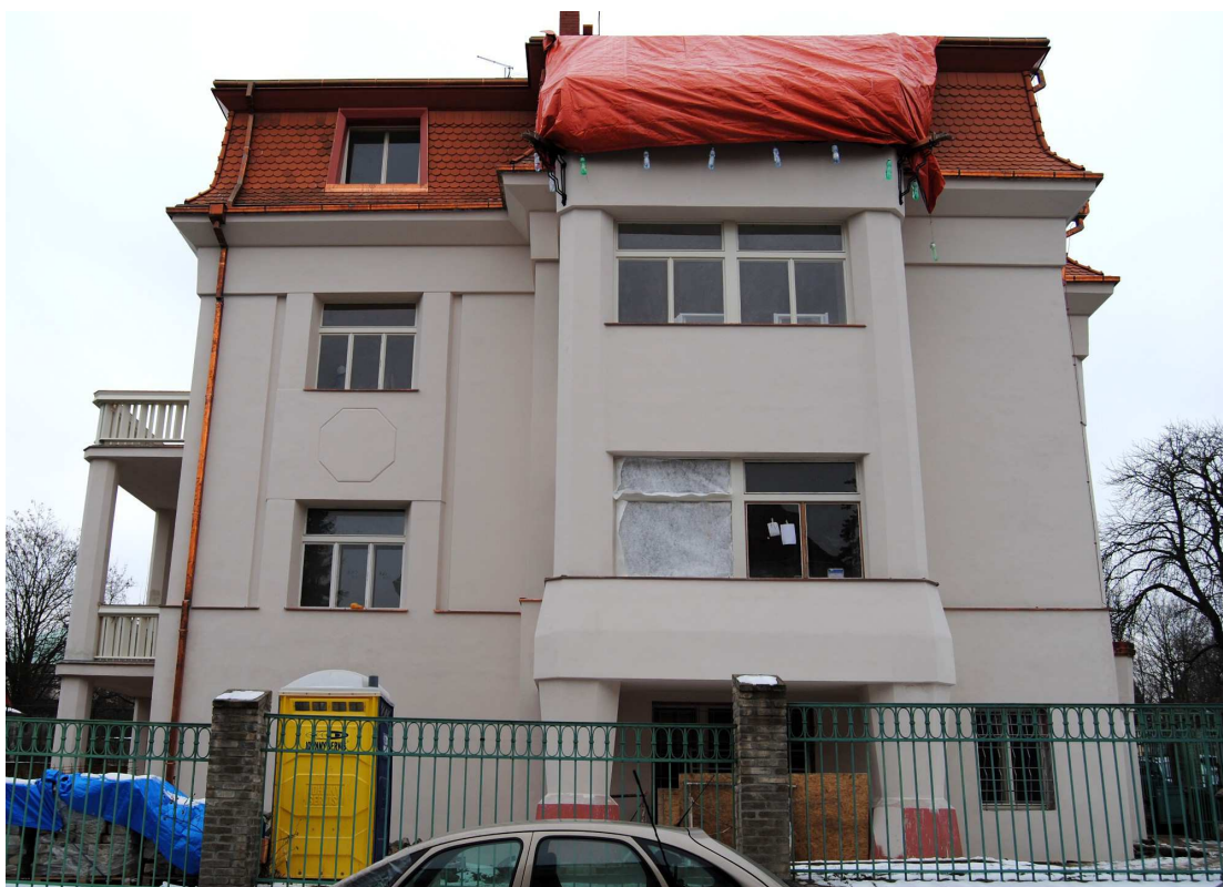
37. Boční (severní) průčelí vily čp. 268, 2014.
