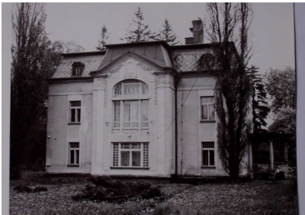
18. Hlavní průčelí, anonymní fotografie, 70. léta.
