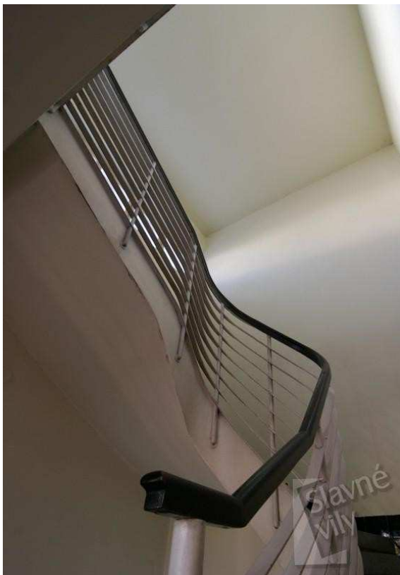
244. Zábradlí schodiště v interiéru, 2008.
