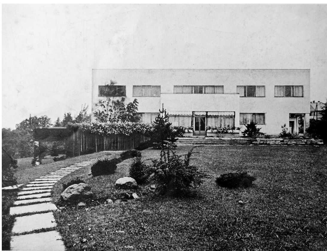
164. Zahradní (jižní) průčelí, nedatováno.
