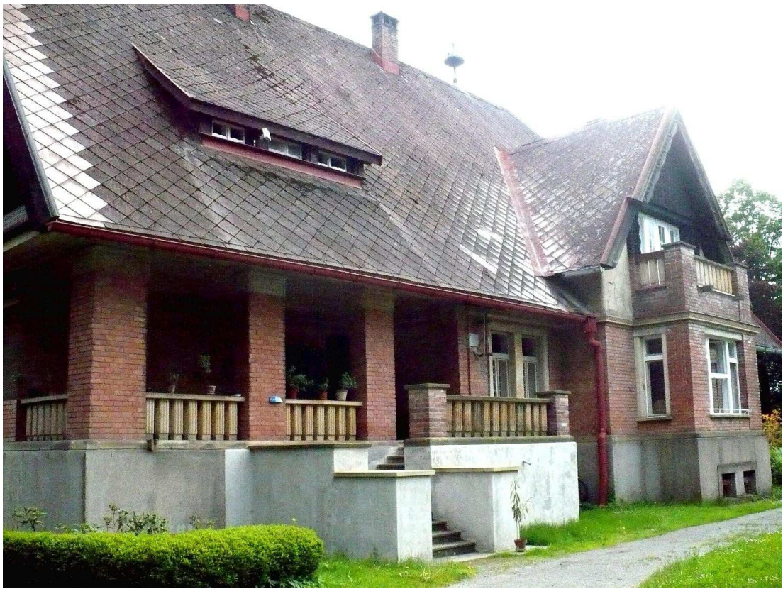
3. Severní průčelí s hlavním vstupem, 2012.
