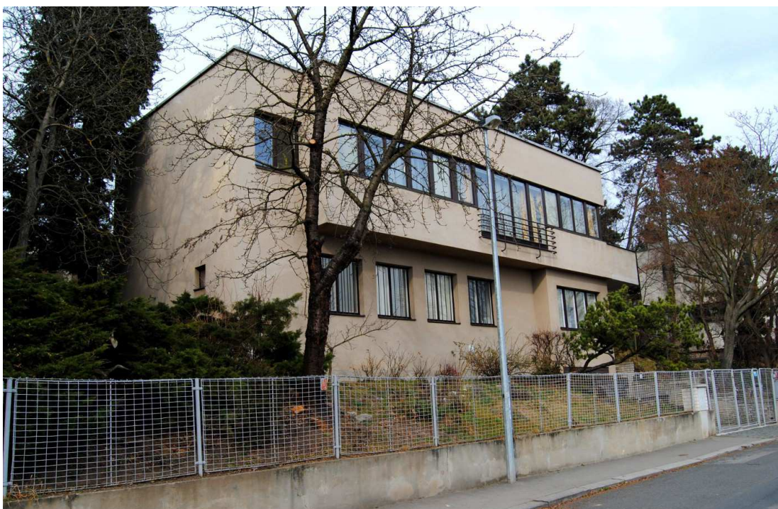
195. Pohled z ulice Nad Paťankou, 2014.
