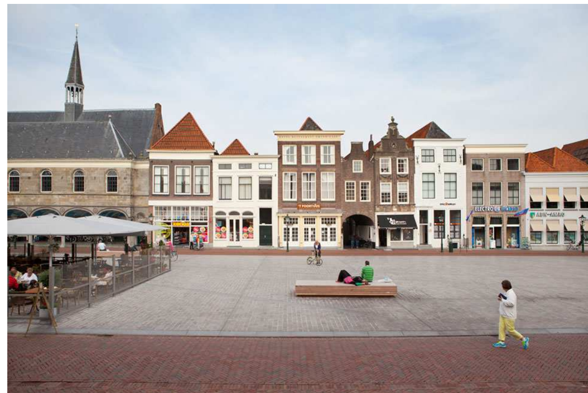
18. Pohled na charakteristickou zástavbu
