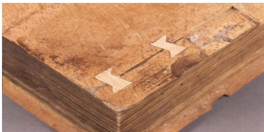
22. Přichycení dřevěné části pomocí spojovacích prvků ve tvaru motýlků.
