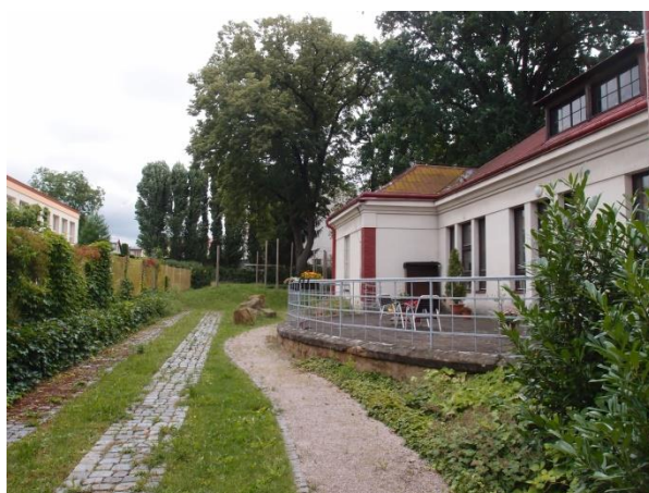
Obr. 51 Vstup do zahrady se severní terasou
