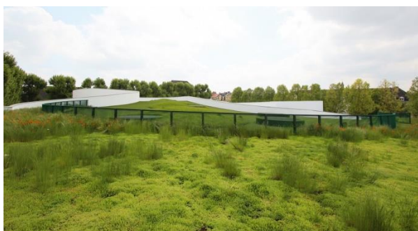
Obr. 33 Vegetace na střeše
