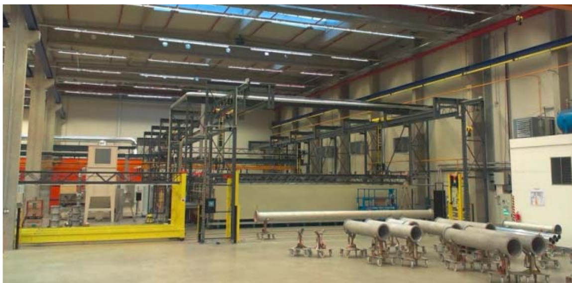
Obr. 4.6 Pohled na lakovnu
