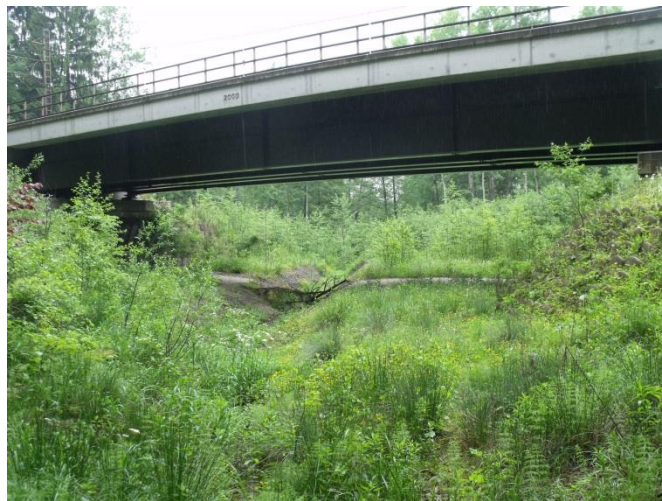
Obrázek 2: Podchod pod železnici č. 320 na koridoru Jablunkov
