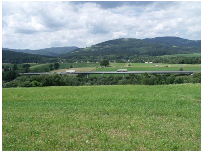
Obrázek 1: Pohled z východu na estakádu č 11-193 na silnici I/11
