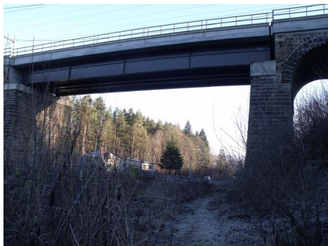
Obrázek 3: Viadukt na železnici č. 320 v Dolní Lomné tvořící první úsek sledované části železnice
