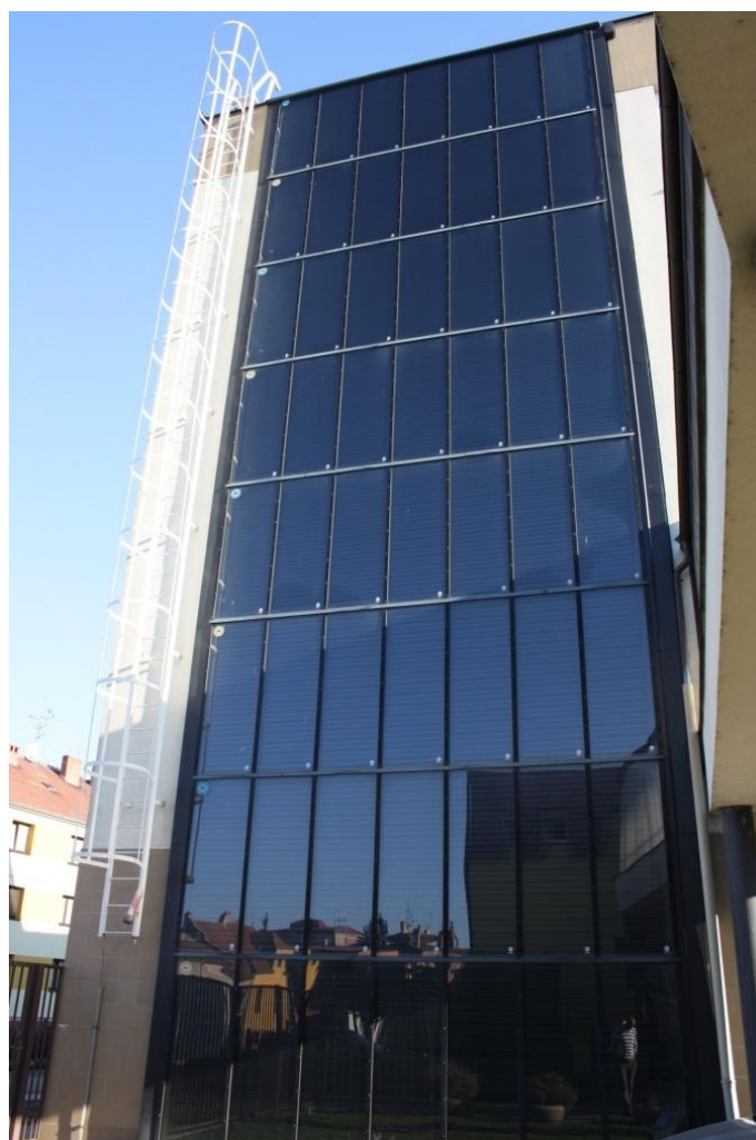
Obr. 3.3: Orientace solárních kolektorů na budově [fotografie autor]
