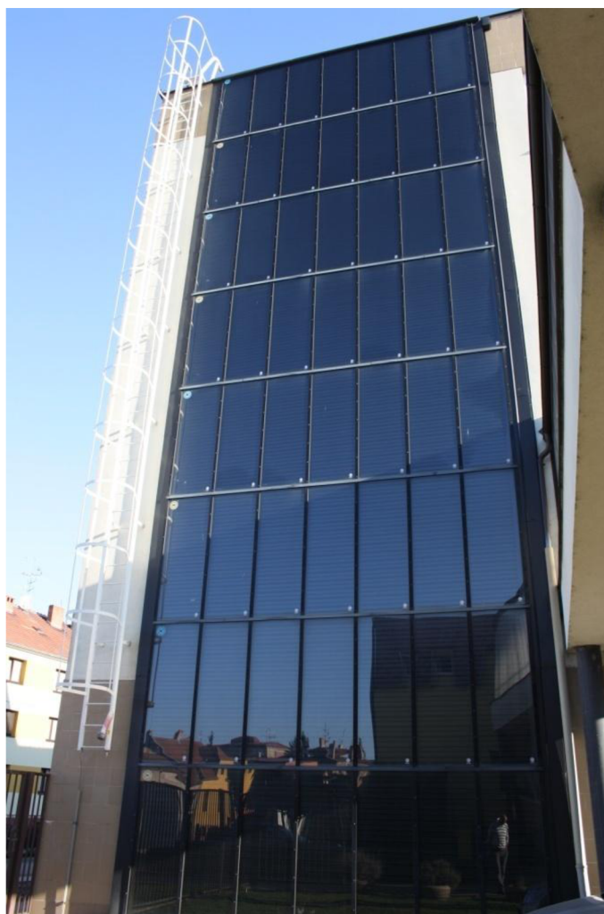
Obr. 3.3: Orientace solárních kolektorů na budově [fotografie autor]
