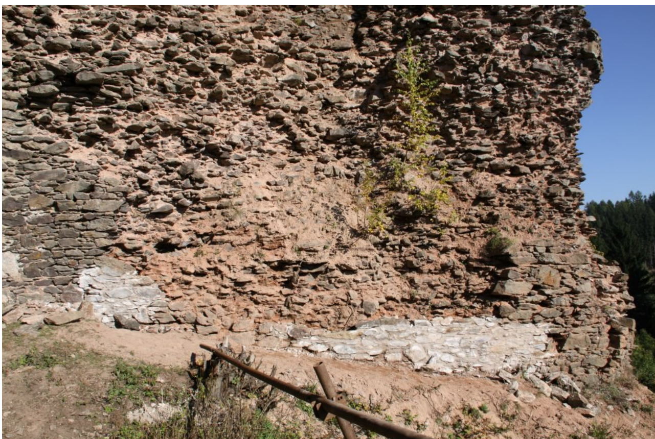
Obr. 12 Sanace zdiva jihozápadního nároží hradu
