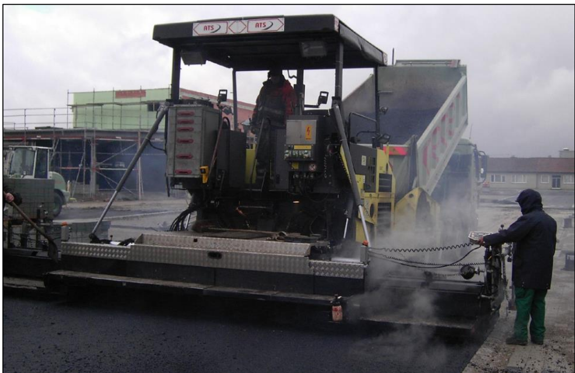
Obr. 15 Finišer pokládá asfalt [13]
