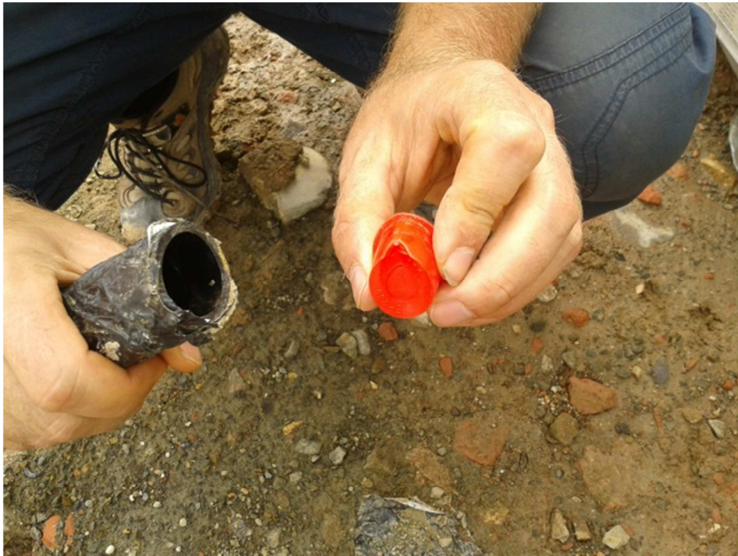
Obr. 55: Deformace ústí trubky.
