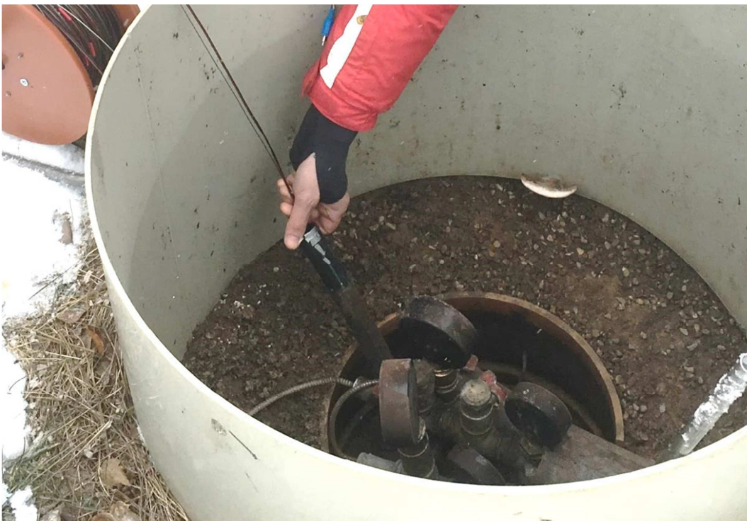
Obr. 65: Detail zhlaví vrtu u nízkoenergetického domu, vkládání sondy do měřicího potrubí vrtu.
