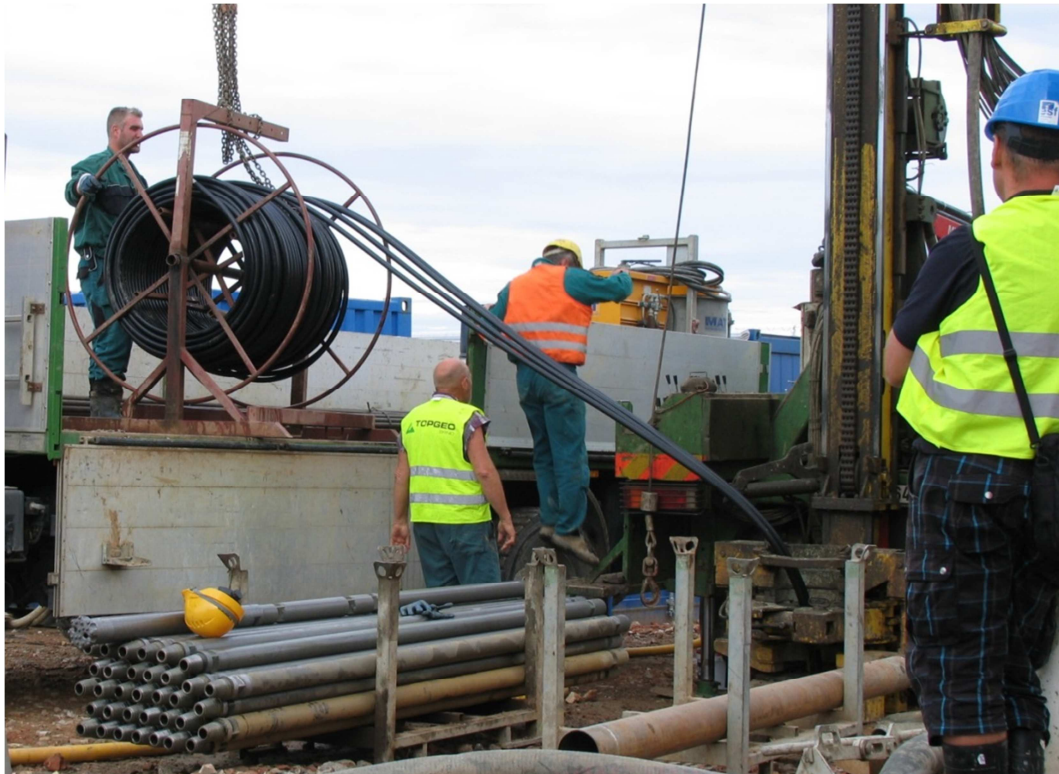
Obr. 18: Instalace geotermálního výměníku (dvojitá U-trubice) do vrtu. (AdMaS 2013, foto autor)
