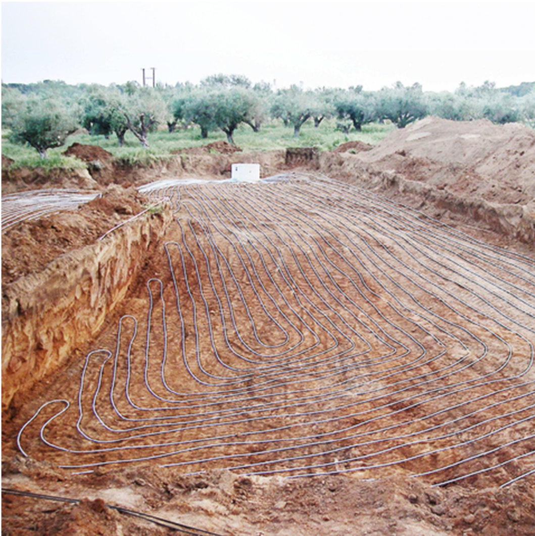
Obr. 14: Zemní plošný kolektor, vinutí sběrného potrubí před zahrnutím zeminou. [17]
