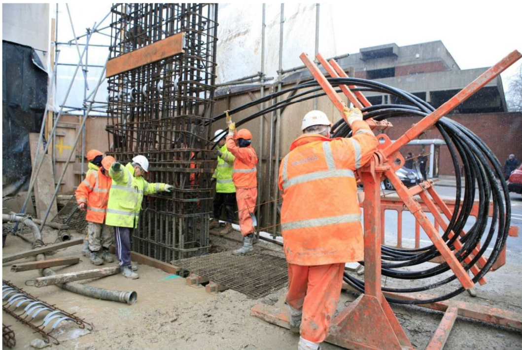
Obr. 12: Hotel Knightsbridge Palace v Londýně, instalace výměníku do armokoše pažící stěny. [16]
