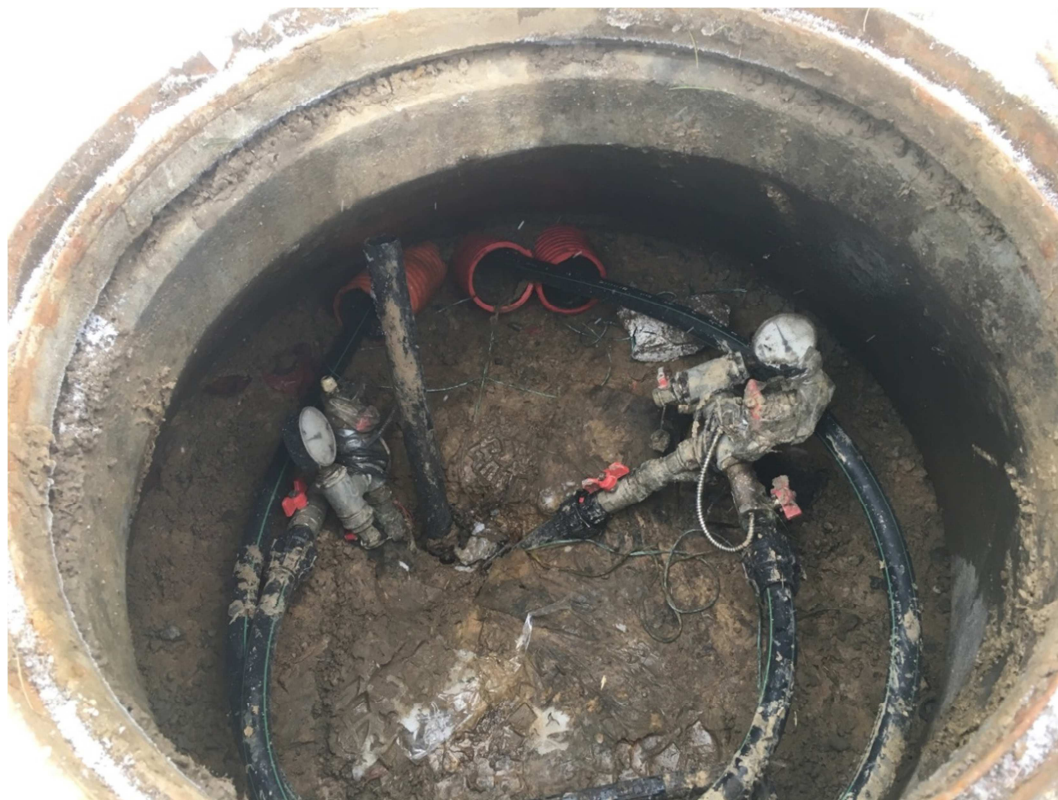
Obr. 61: Zhlaví vrtu E0 v blízkosti VEC TU Ostrava.
