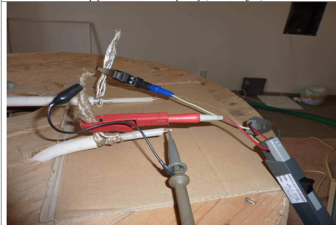
Propojení kabelu s měřicími přístroji (stínění + signál)
