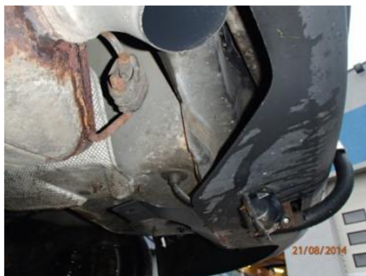
Obrázok 86: Pohľad zospodu na možné ďalšie poškodenia
