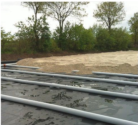
Obrázek 15 - Písková vrstva (dělicí vrstva)
